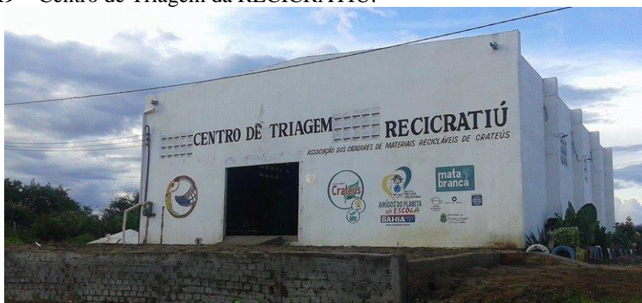
Figura 3.19 – Centro de Triagem da RECICRATIÚ.
