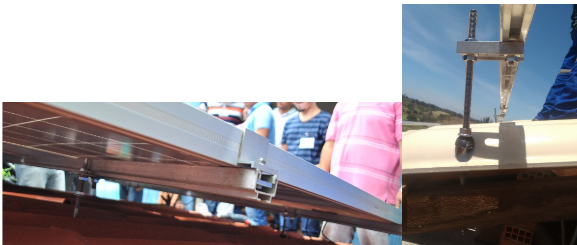
Figura 3 – Estruturas de fixação para telhados cerâmicos de diferentes fabricantes.
