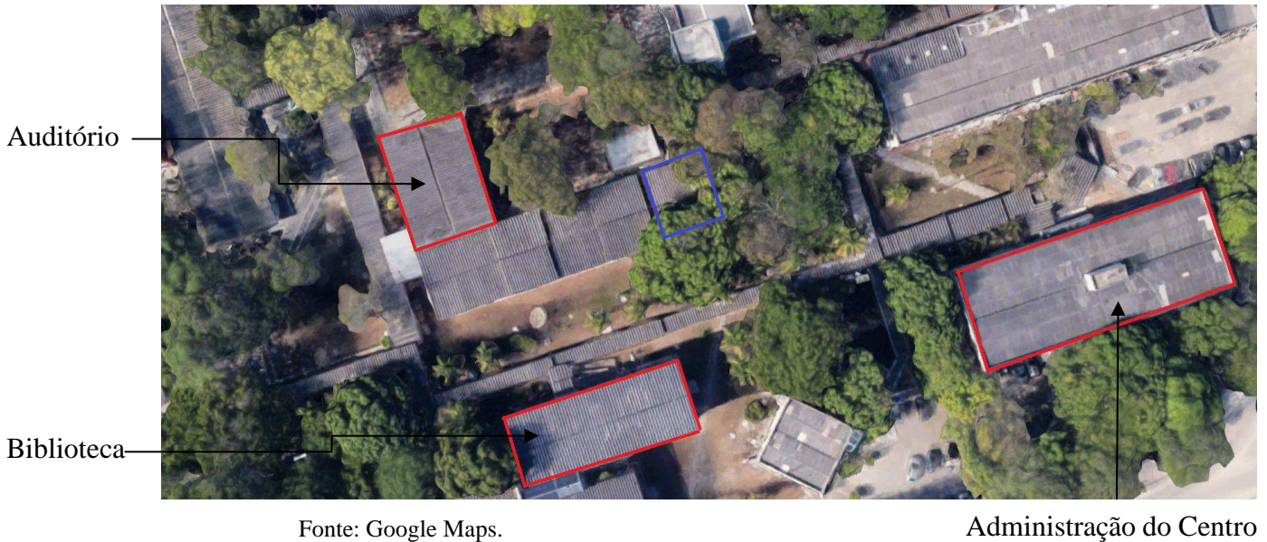
Figura 8 - localização da sala de testes em geradores (menor escala).
