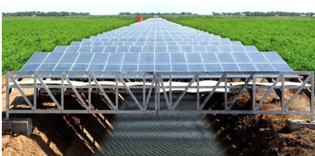
Figura 12: Sistema fotovoltaico em canal de integração na Índia.
