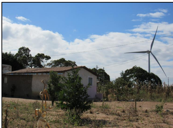
Figura 62 – Aerogerador localizado no quintal de uma residência na comunidade quilombola Macambira em Lagoa Nova, Bodó e Santana do Matos (RN)
