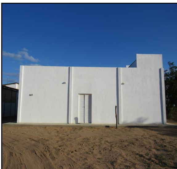
Figura 65 – Casa de farinha em construção na comunidade quilombola Macambira em Lagoa Nova, Bodó e Santana do Matos (RN)
