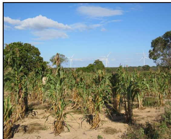
Figura 64 - Aerogeradores próximos a área de plantio de milho na comunidade quilombola Macambira em Lagoa Nova, Bodó e Santana do Matos (RN)
