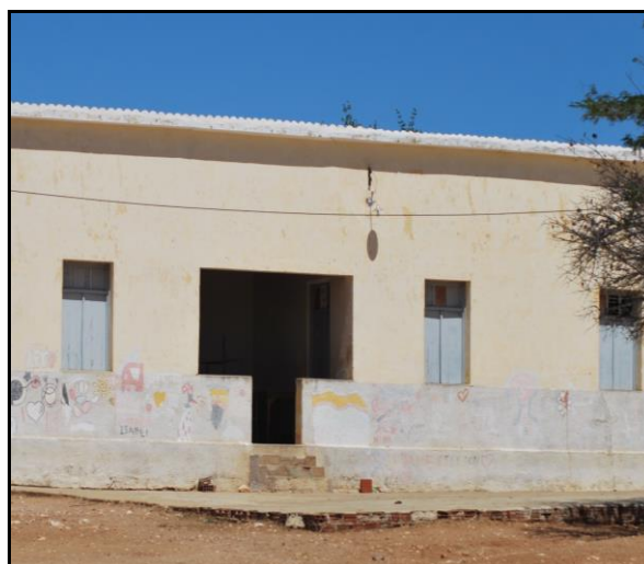
Figura 36 - Escola desativada na comunidade quilombola Boa Vista, Parelhas (RN)
