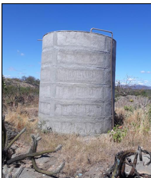
Figura 41 – Poço construído através do Programa Governo Cidadão na comunidade quilombola Boa Vista dos Negros, Parelhas (RN)
