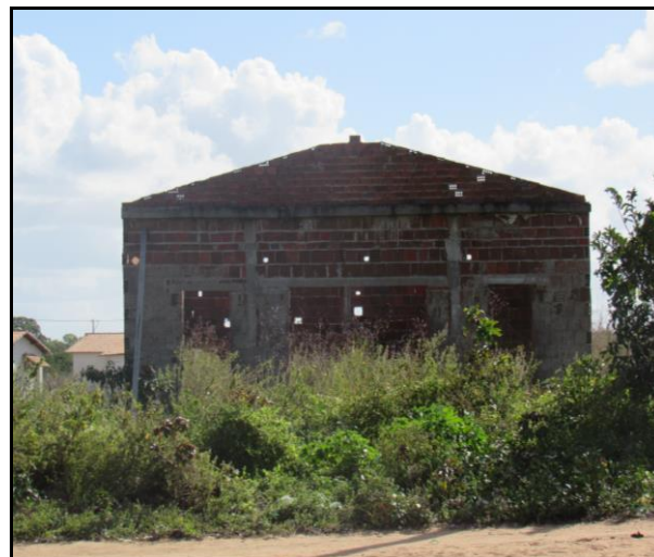
Figura 26 – Capela em construção na comunidade quilombola Acauã, Poço Branco (RN)
