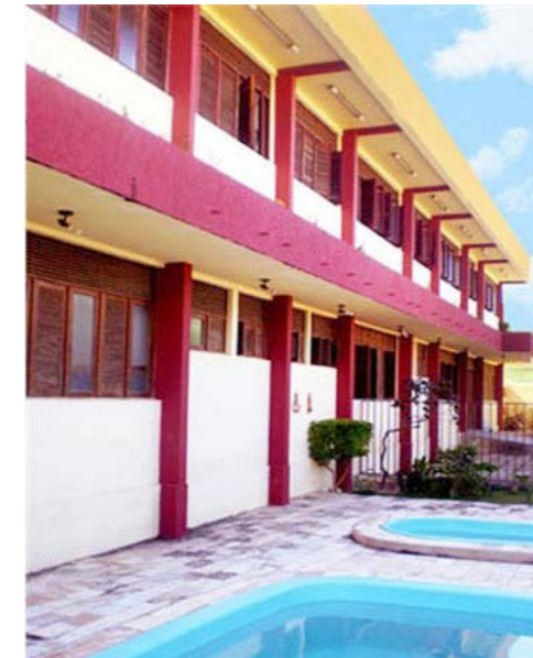
FIGURA 1 - Fachada do CETL
