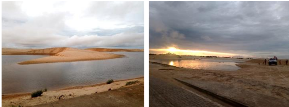
Figura 11 – Dunas e lagoas às margens da Ecorodovia MA-315
