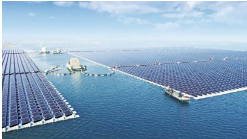
Figura 23 - Planta FV de 40MWp, em Huainan, China.
