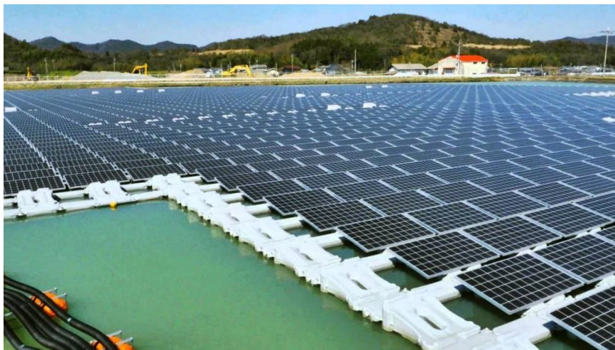
Figura 24 - Usina solar flutuante no reservatório da usina hidrelétrica de Balbina.
