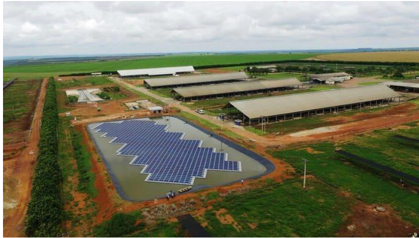
Figura 25 - Planta FV flutuante instalada na fazenda Figueiredo, Goiás.
