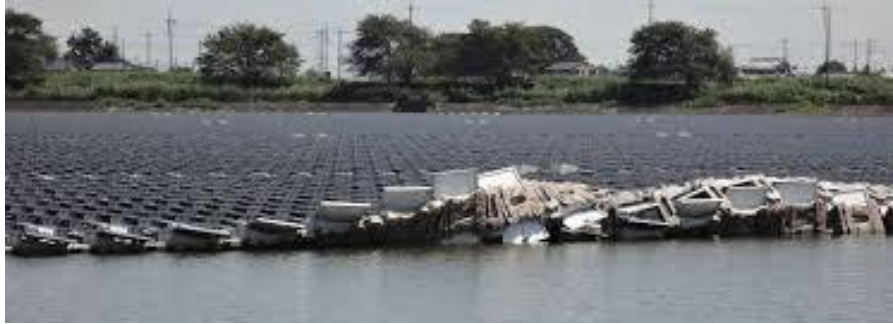
Figura 19 - Acidente em planta FV flutuante instalada em Kawajima-Machi, no Japão.
