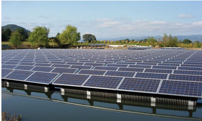
Figura 21 - Primeira planta FV flutuante comercial, instalada em Far Niente, Califórnia, em 2008.
