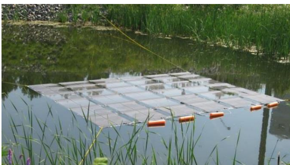
Figura 14 - Exemplo de planta FV flutuante utilizando tecnologia de filme fino.
