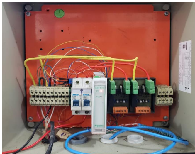
Figura 31 – Sensores de tensão e corrente conectados ao módulo remoto.
