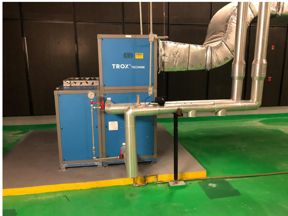
Figura 23: Fancoil da casa de máquinas.
