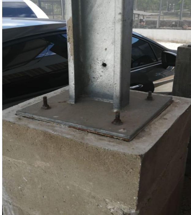
Figura 20 – Aterramento estrutural do sistema
