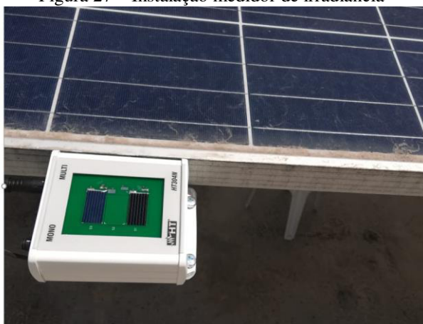
Figura 27 – Instalação medidor de irradiância
