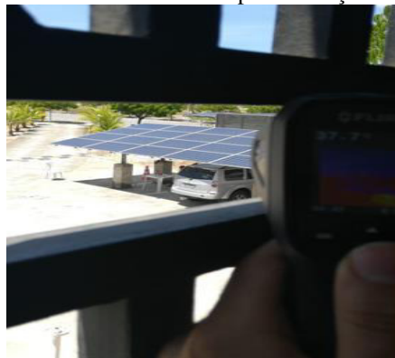
Figura 49 – Utilização da Câmera infravermelho para detecção de pontos quentes nos painéis
