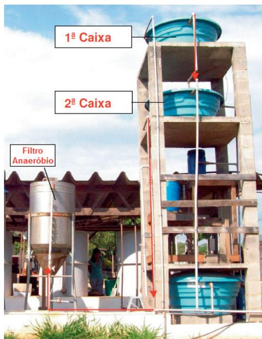
Figura 1: Esquema das caixas de armazenamento e de alimentação dos filtros anaeróbios.
