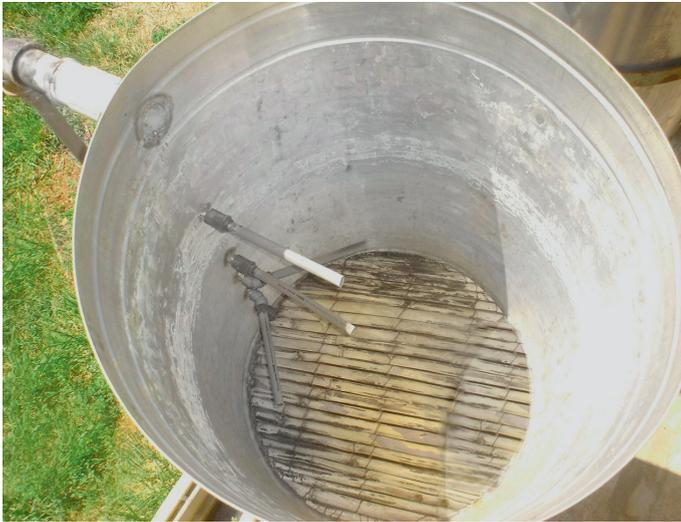
**Figura 3:** Detalhe da grade de bambu instalada no limite do cone e do cilindro do reator anaeróbio.
