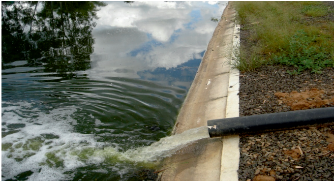
Figura 08 - Drenagem dos BAGs e retorno para ETE Coronel Macedo
