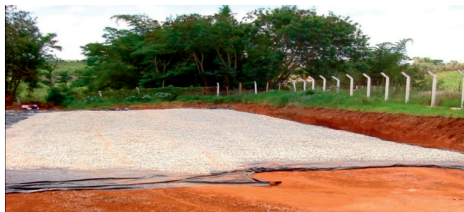
Figura 05 - Preparação do leito para instalação dos BAGs. ETE Coronel Macedo, SABESP.
