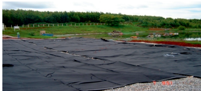
Figura 06 - Assentamento dos BAGs para remoção de lodo da ETE Coronel Macedo, SABESP.
