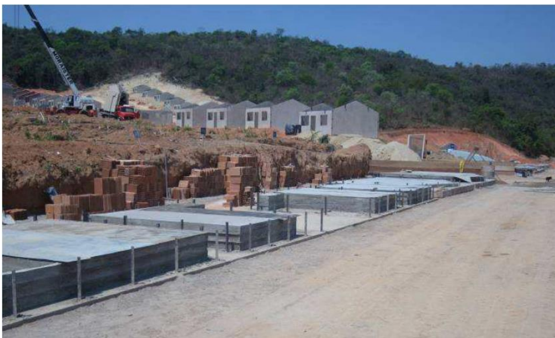
Figura 84 – Vista geral de pista de concreto para fabricação de painéis do sistema DHARMA
