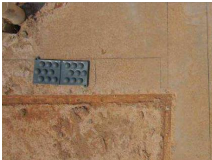
Figura 100 – Posicionamento de espaçadores plásticos para apoio do painel do sistema DHARMA durante a montagem
