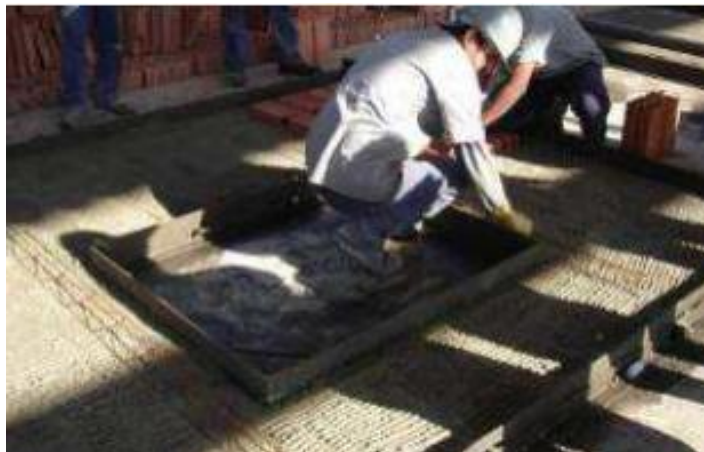
Figura 60 – Posicionamento de treliça de reforço nas aberturas de vão de porta e janela no painel do sistema CASA EXPRESS
