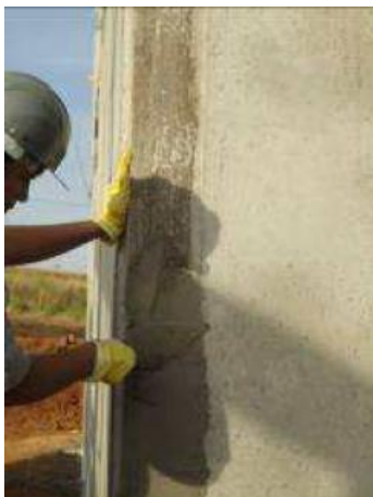
Figura 78 – Acabamento das juntas com argamassa nos painéis do sistema CASA EXPRESS
