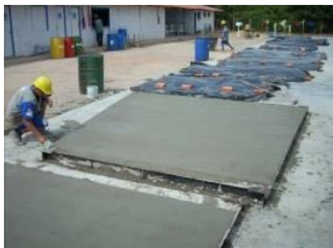
Figura 138 – Acabamento e cura do painel com lona plástica no sistema Olé
