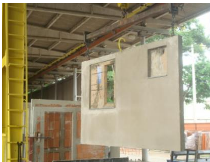
Figura 115 – Desenforma e transporte do painel do sistema construtivo PRECON
