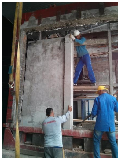
Figura 181 – Posicionamento do primeiro painel do pilar pré-moldado no pórtico
