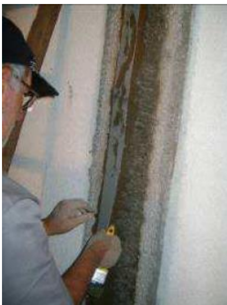
Figura 77 – Aplicação de tela de poliéster com argamassa colante AC I nas juntas entre painéis do sistema CASA EXPRESS
