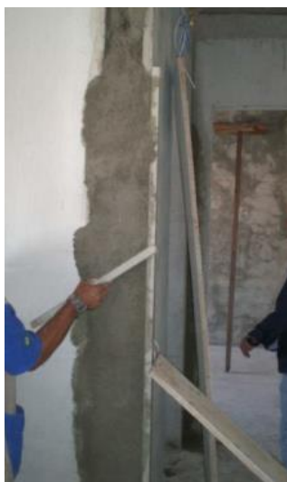
Figura 142 – Preenchimento e acabamento das juntas entre painéis do sistema Olé
