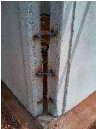
Figura 70 – Solda entre armaduras de ligação com dois painéis do sistema CASA EXPRESS
