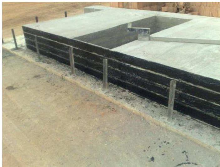
Figura 96 – Base dos painéis do sistema DHARMA com emulsão asfáltica aplicada
