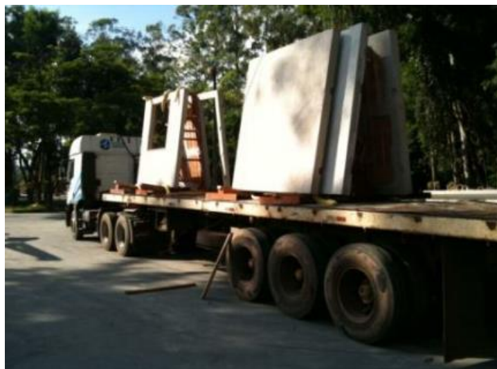
Figura 116 – Transporte dos painéis do sistema PRECON
