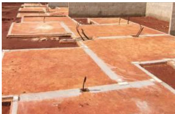
Figura 41 – Locação para correto posicionamentos dos painéis do sistema JET CASA sobre a fundação
