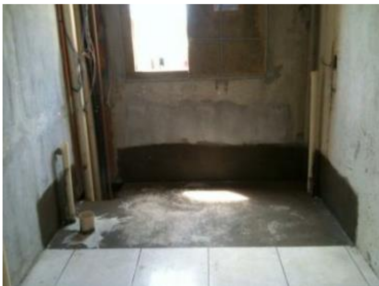
Figura 127 – Impermeabilização de laje e rodapé do painel em 30 cm nas áreas molhadas do sistema PRECON
