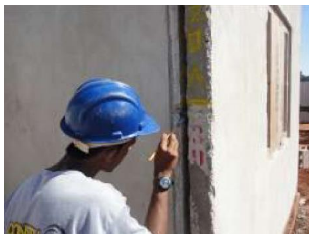
Figura 44 – Proteção anti-corrosiva aplicada com primer epóxi nas ligações entre painéis do sistema JET CASA
