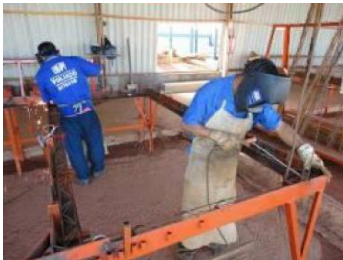
Figura 29 – Preparação das armaduras na central de armação com utilização de gabarito no sistema JET CASA
