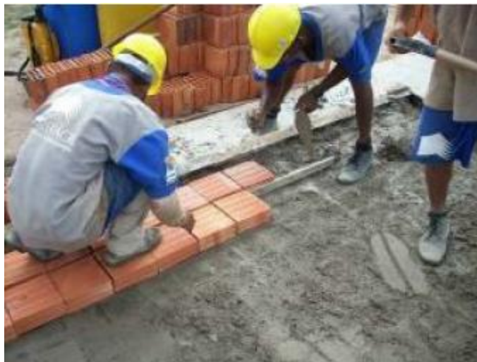
Figura 135 – Distribuição de blocos cerâmicos sobre primeira camada de concreto do painel do sistema Olé
