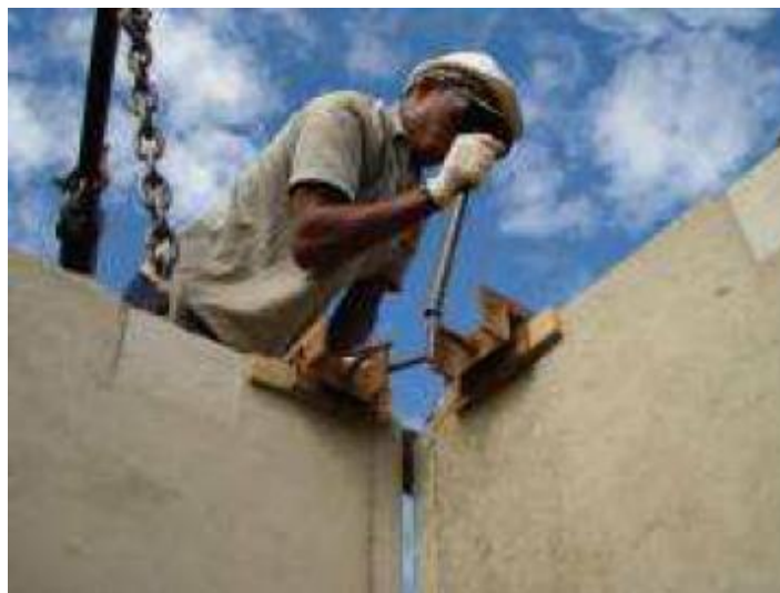
Figura 69 – Travamento superiores nos painéis do sistema CASA EXPRESS durante a montagem
