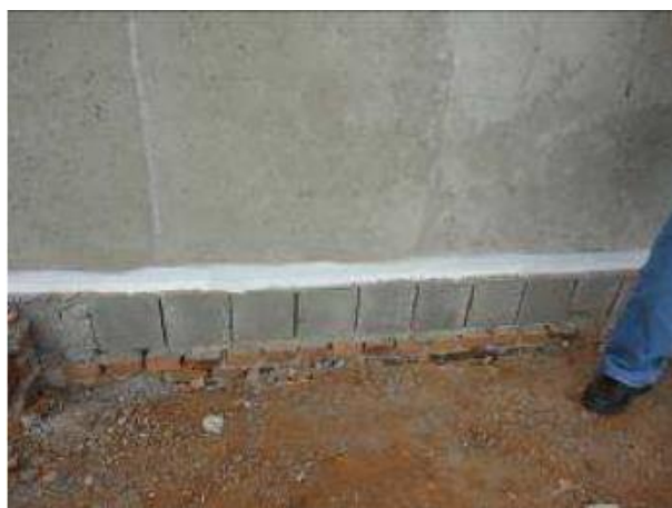
Figura 75 – Aplicação de emulsão acrílica sobre a argmassa de regularização da base dos painéis do sistema CASA EXPRESS
