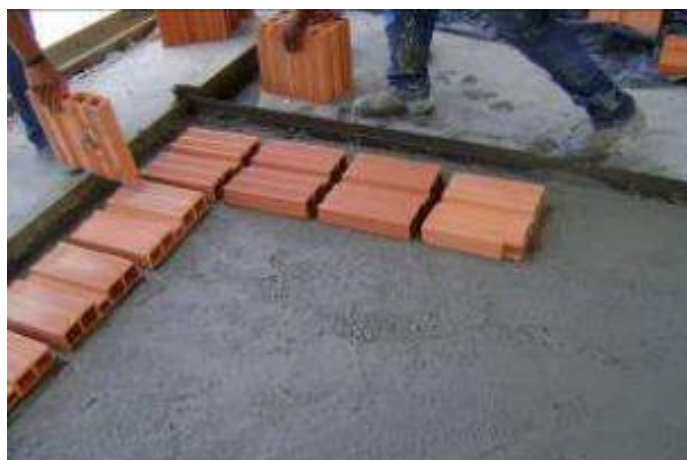
Figura 61 – Posicionamento dos blocos cerâmicos no painel do sistema CASA EXPRESS
