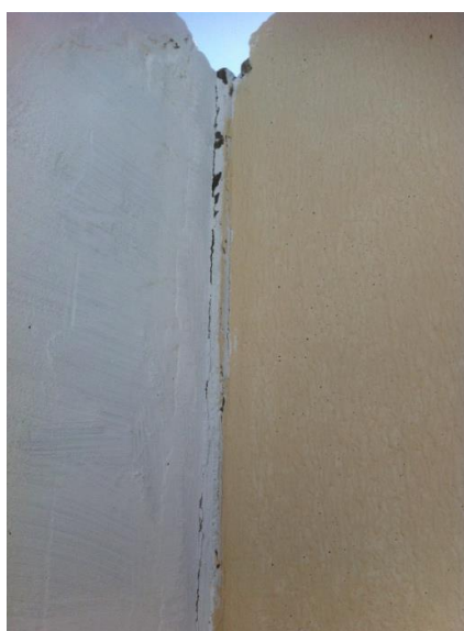
Figura 162 – Fissura ocorrida na ligação do painel com o pilar pré-moldado após a energia de 960 J com impacto pelo lado do concreto
