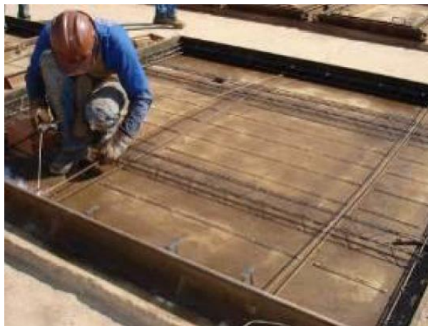
Figura 30 – Posicionamento das armaduras na forma do sistema JET CASA
