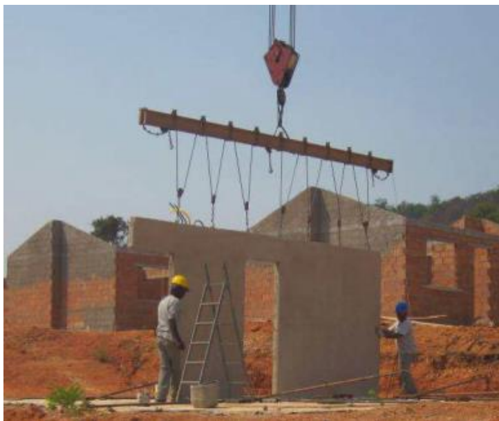
Figura 101 – Descarregamento e posicionamento do painel do sistema DHARMA durante a montagem
