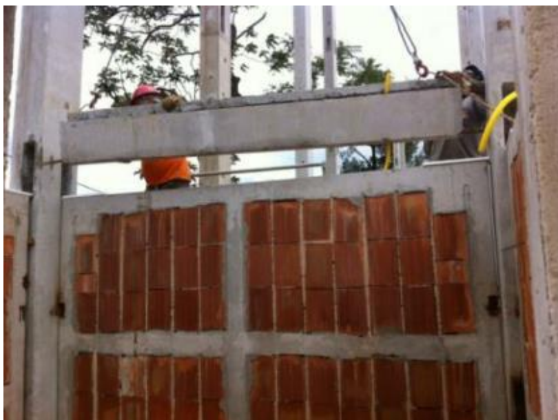
Figura 124 – Posicionamento da viga sobre o painel pré-fabricado do sistema PRECON
