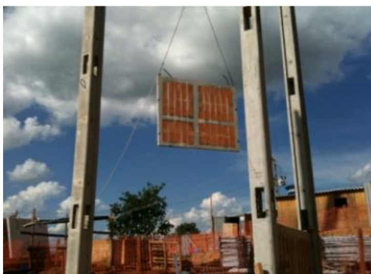
Figura 118 – Montagem dos painéis do sistema PRECON
