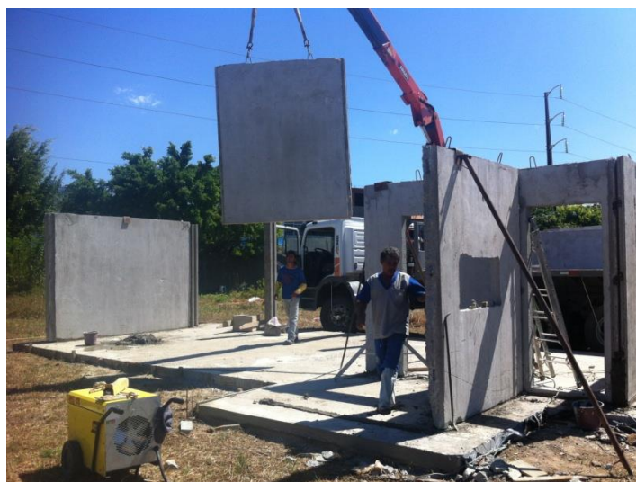
Figura 146 – Montagem dos painéis do protótipo
