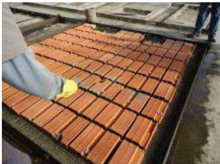
Figura 62 – Posicionamento da armadura inferior do painel do sistema CASA EXPRESS
