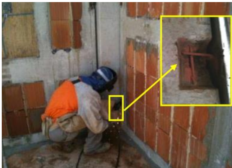
Figura 123 – Nichos dos painéis para ligação do painel com o pilar por meio de solda elétrica no sistema construtivo PRECON
