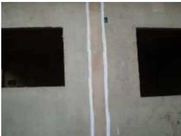
Figura 79 – Aplicação de emulsão acrílica após endurecimento de argamassa das juntas entre painéis do sistema CASA EXPRESS
