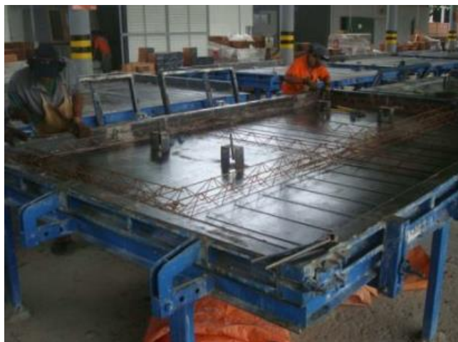
Figura 109 – Posicionamento das armaduras nas nervuras de concreto na forma do painel do sistema PRECON
