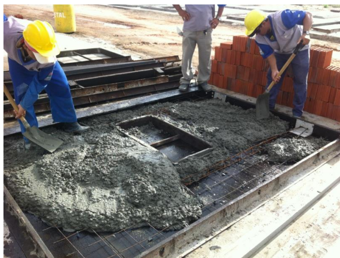
Figura 144 – Moldagem do painel da unidade protótipo montada no NUTEC
