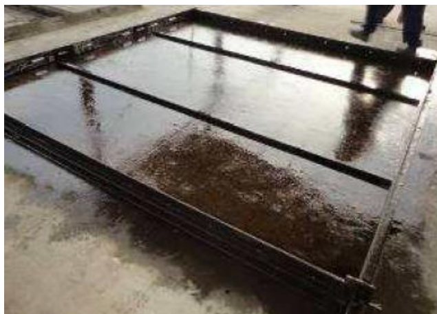
Figura 58 – Preparação das formas do sistema CASA EXPRESS e aplicação de desmoldante
