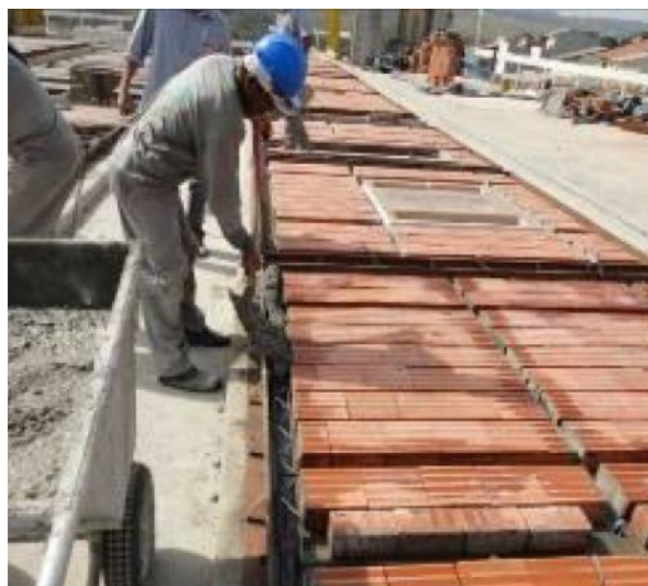
Figura 33 – Lançamento de concreto nas nervuras do painel do sistema JET CASA
