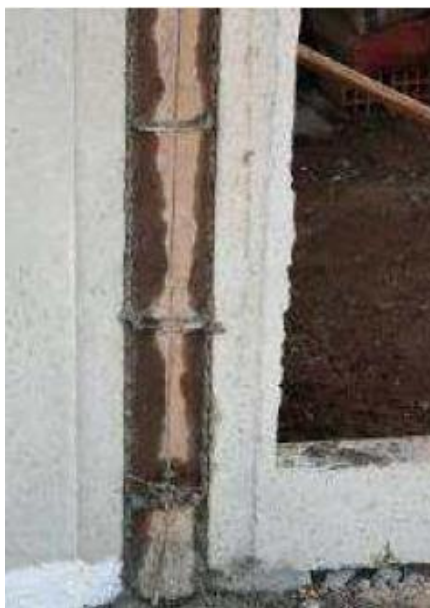
Figura 76 – Preenchimento das juntas entre painéis do sistema CASA EXPRESS
