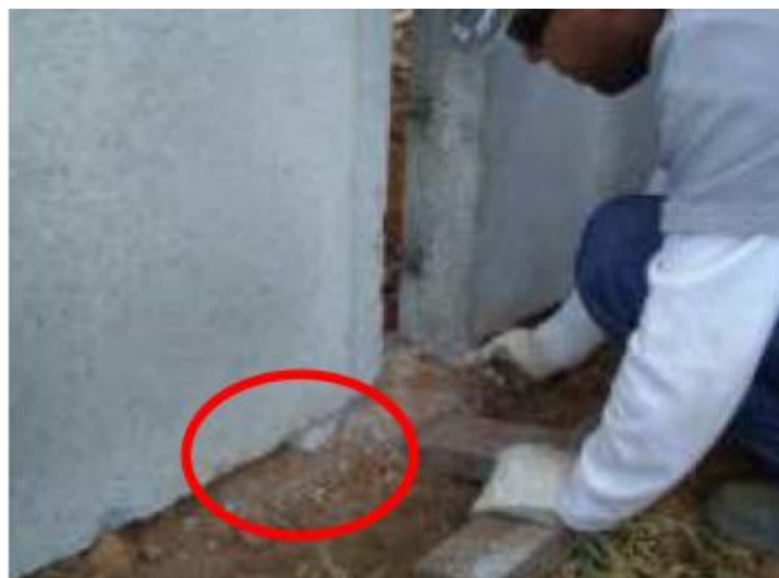
Figura 73 – Inserção de calços de argamassa na interface entre painéis e fundação do sistema CASA EXPRESS
