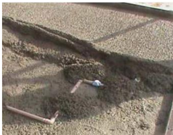
Figura 67 – Lançamento de concreto ( f_{ck} = 12 MPa) sobre tubulações hidráulicas no painel do sistema CASA EXPRESS
