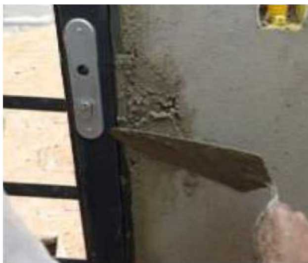
Figura 81 – Chumbamento das esquadrias com argamassa no painel do sistema CASA EXPRESS
