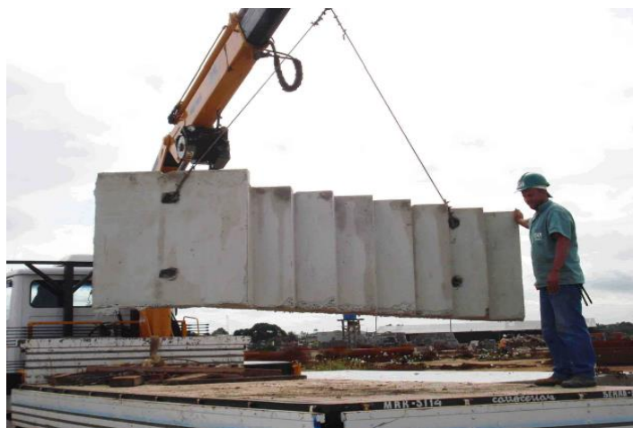
Figura 7 – Transporte de escada pré-fabricada em grandes dimensões
