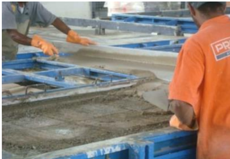
Figura 114 – Aplicação de argamassa e acabamento na face superior do painel do sistema PRECON
