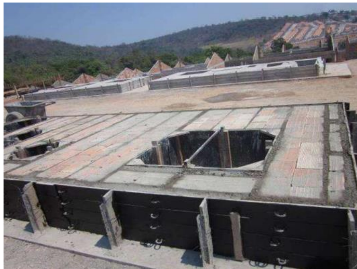
Figura 94 – Nervuras concretadas no painel do sistema DHARMA
