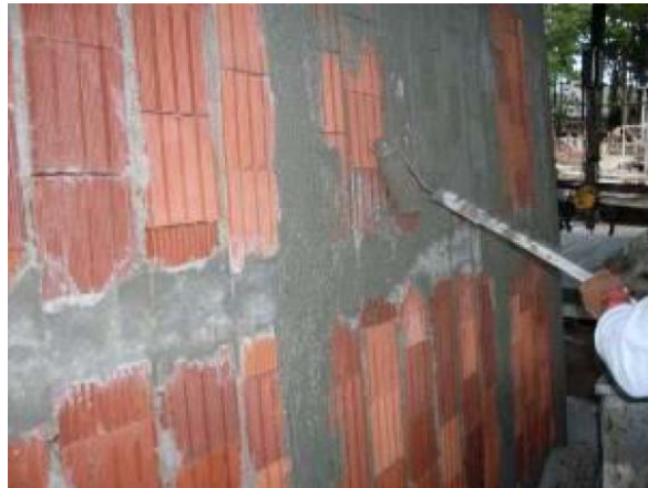
Figura 39 – Aplicação de chapisco na segunda face do painel do sistema JET CASA
