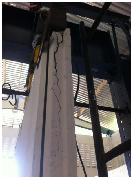
Figura 158 – Modo de ruptura do corpo de prova 02 durante o estado último de resistência (interface concreto-blocos cerâmicos)
