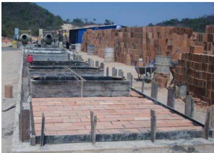
Figura 85 – Vista da moldagem dos painéis do sistema DHARMA
