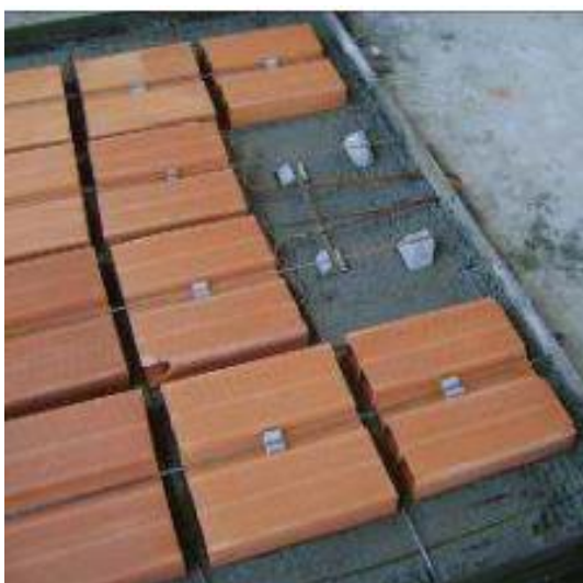
Figura 63 – Posicionamento da armadura superior do painel do sistema CASA EXPRESS
