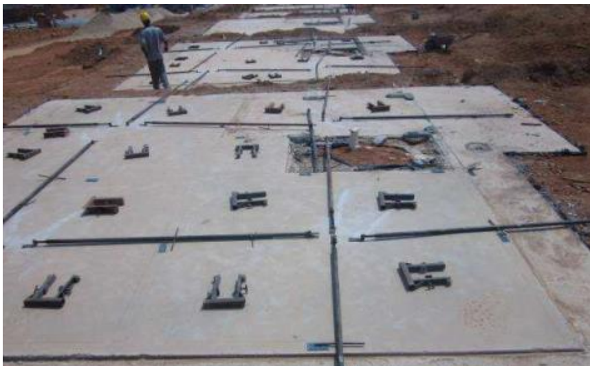
Figura 99 – Fixação das escoras metálicas para apoio dos painéis do sistema DHARMA
