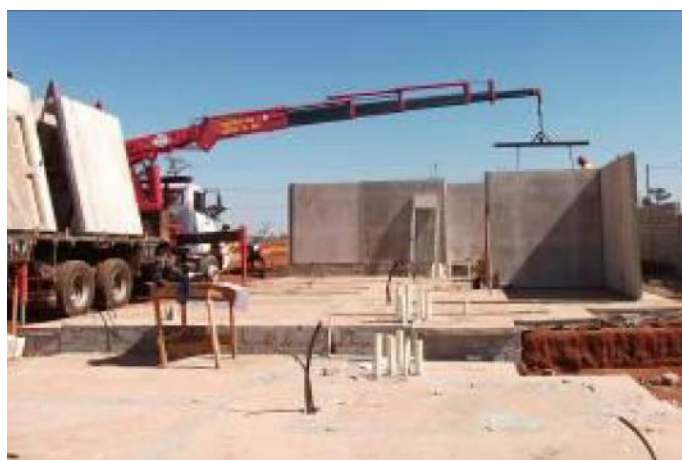
Figura 42 – Posicionamento dos painéis sobre a fundação no sistema JET CASA
