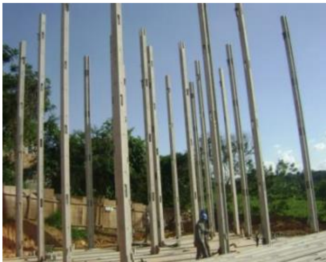
Figura 117 – Montagem dos pilares do sistema PRECON
