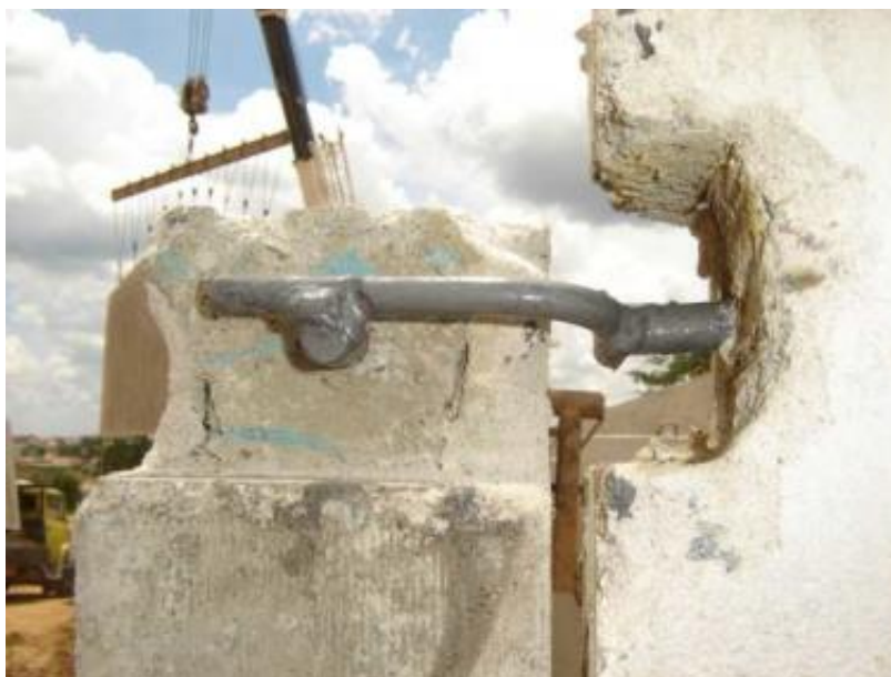
Figura 89 – Detalhe de solda entre barras de esperas e proteção contra corrosão nas ligações entre painéis do sistema DHARMA
