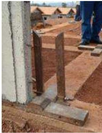
Figura 68 – Guias provisórias para posicionamento dos painéis do sistema CASA EXPRESS sobre a fundação
