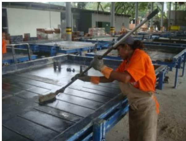
Figura 108 – Aplicação de desmoldante em forma metálica do sistema PRECON
