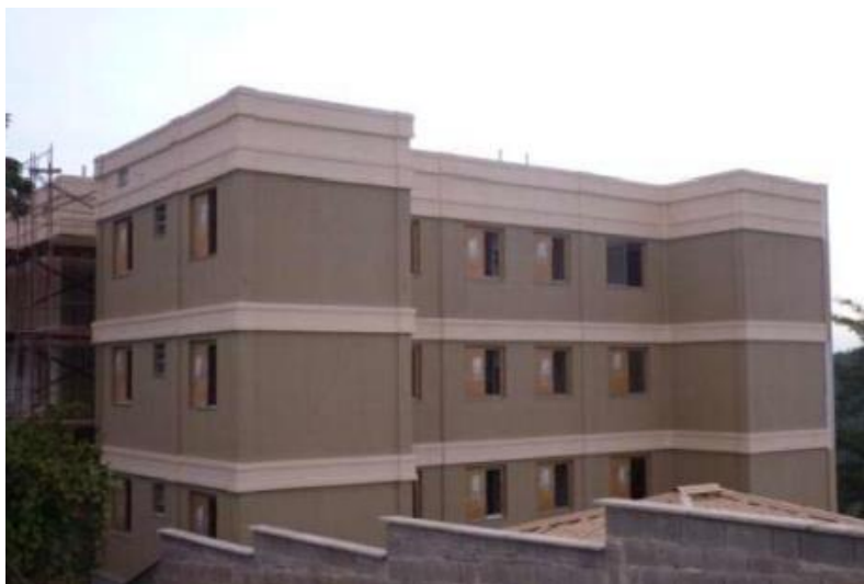
Figura 120 – Edifício habitacional finalizado com o uso do sistema construtivo PRECON
