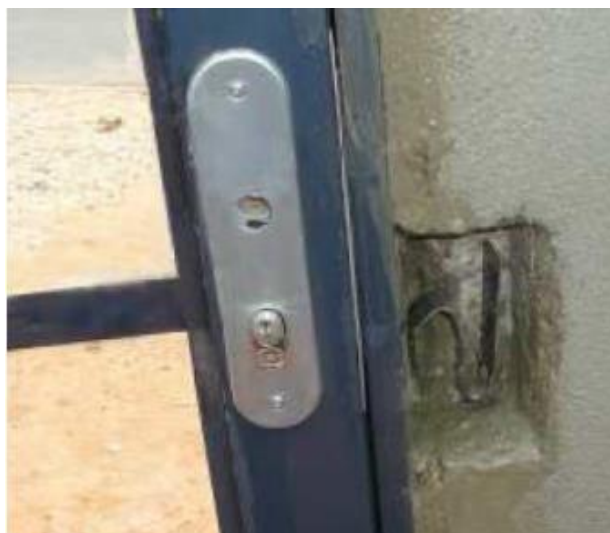
Figura 80 – Instalação da porta conforme rebaixos existentes no painel do sistema CASA EXPRESS
