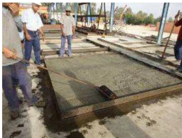
Figura 59 – Adensamento do concreto da primeira camada do painel do sistema CASA EXPRESS
