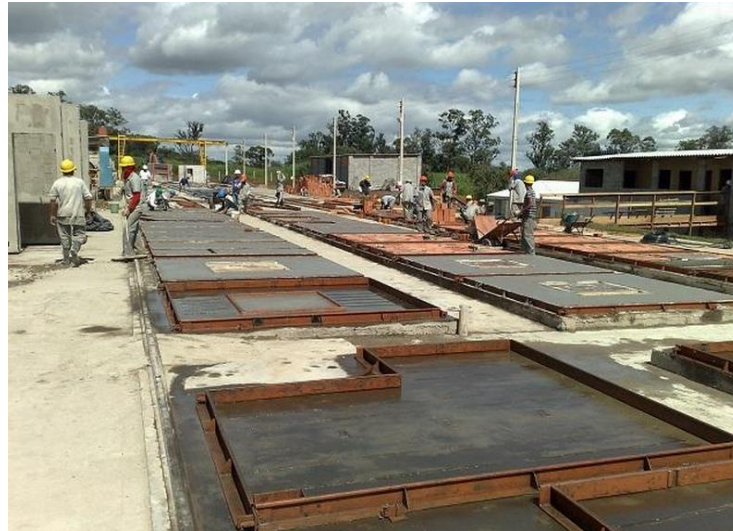
Figura 28 – Forma preparada para o recebimento da armadura no sistema JET CASA
