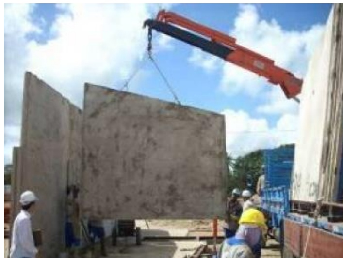
Figura 140 – Montagem do painel Olé no local final da edificação
