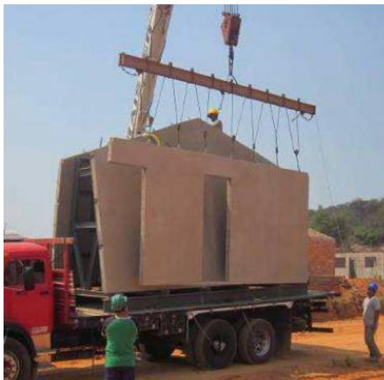
Figura 97 – Carregamento e transporte dos painéis do sistema DHARMA
