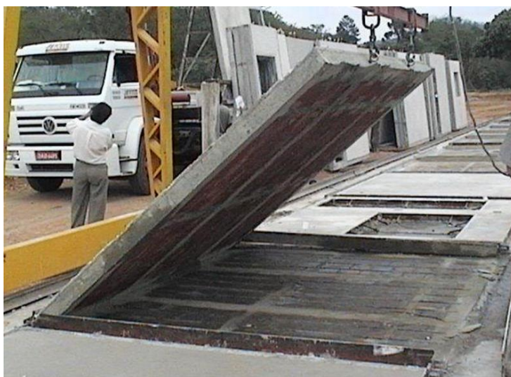
Figura 37 – Içamento do painel do sistema JET CASA
