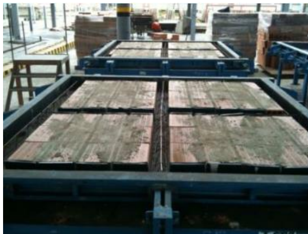
Figura 112 – Aplicação de argamassa na junta entre os blocos do painel do sistema PRECON
