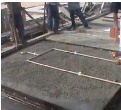
Figura 66 – Posicionamento de tubulações hidráulicas em painel do sistema CASA EXPRESS
