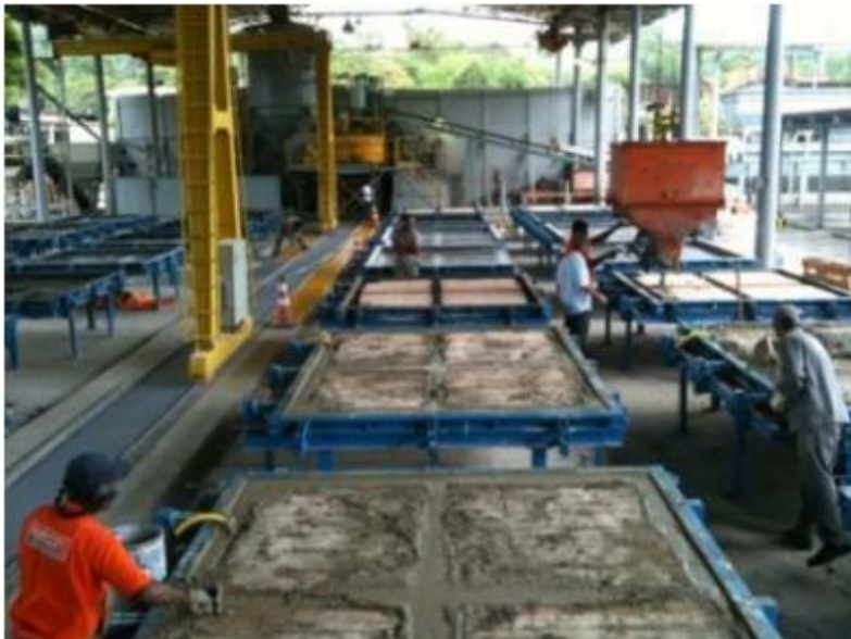
Figura 113 – Concretagem das nervuras dos painéis do sistema PRECON
