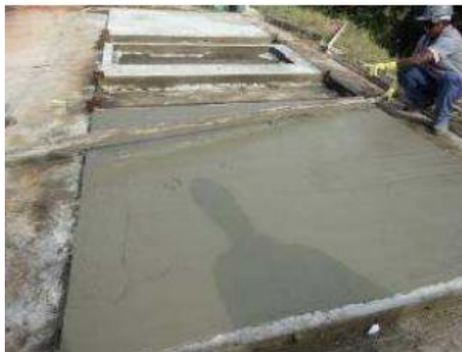
Figura 65 – Acabamento da camada de argamassa executada sobre a segunda camada de concreto do painel do sistema CASA EXPRESS
