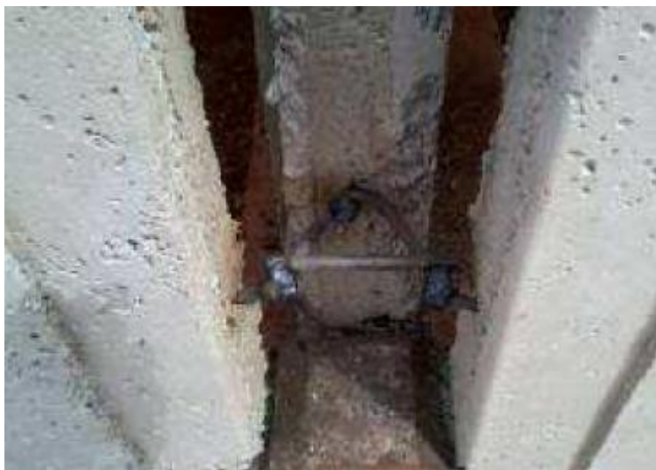
Figura 71 – Detalhe de solda de ligação entre três painéis do sistema CASA EXPRESS
