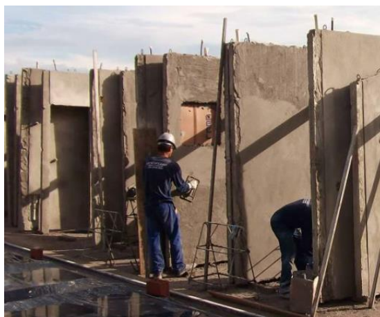
Figura 40 – Revestimento da segunda face do painel do sistema JET CASA aplicado convencionalmente
