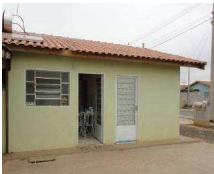
Figura 83 – Unidade habitacional finalizada e construída com o sistema construtivo CASA EXPRESS
