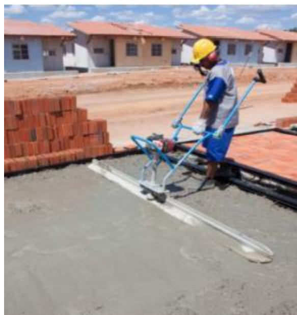
Figura 134 – Lançamento e adensamento do concreto da primeira camada do painel do sistema Olé
