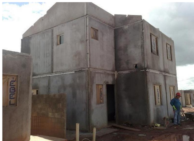
Figura 47 – Lajes posicionadas sobre painéis em unidade sobrada em Campinas-SP do sistema JET CASA
