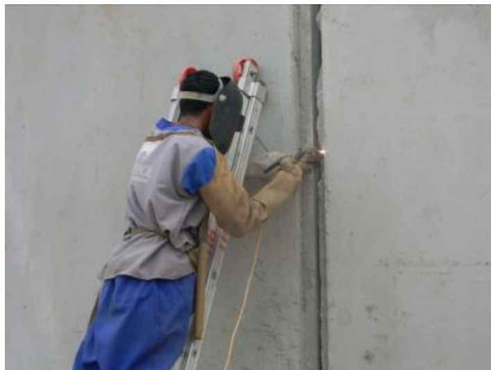
Figura 141 – Execução de solda de ligação entre painéis do sistema Olé
