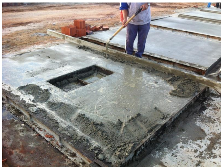
Figura 145 – Acabamento dos painéis utilizados no protótipo
