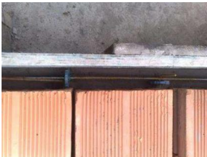
Figura 92 – Posicionamento das armaduras e blocos cerâmicos no painel do sistema DHARMA
