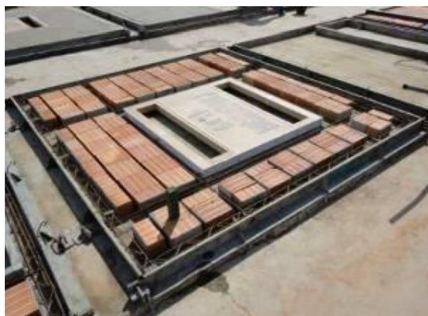
Figura 31 – Blocos cerâmicos inseridos na forma do sistema JET CASA
