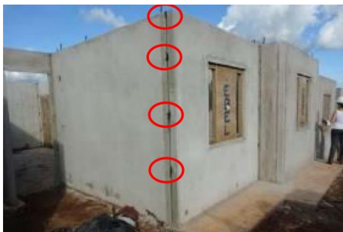
Figura 43 – Pontos de solda executados nas ligações entre painéis do sistema JET CASA
