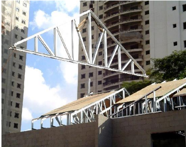
Figura 14 – Estrutura metálica pré-fabricada para cobertura
