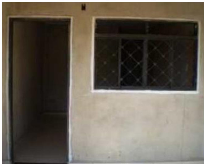
Figura 82 – Aplicação de emulsão acrílica no perímetro das esquadrias no painel do sistema CASA EXPRESS
