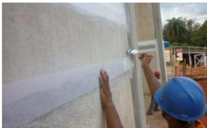
Figura 119 – Tratamento das juntas no sistema PRECON
