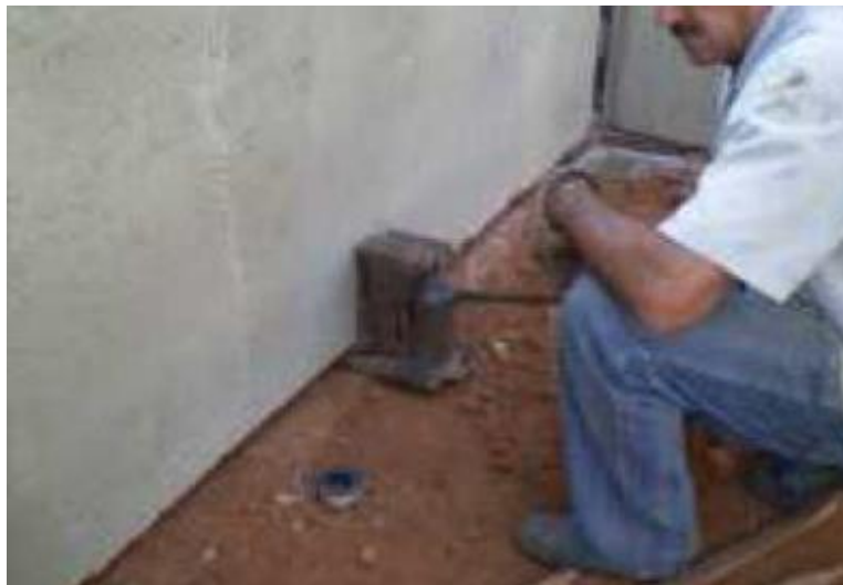
Figura 72 – Suspensão do painel com macaco hidráulico para retirada das bases de ferro sob os painéis do sistema CASA EXPRESS
