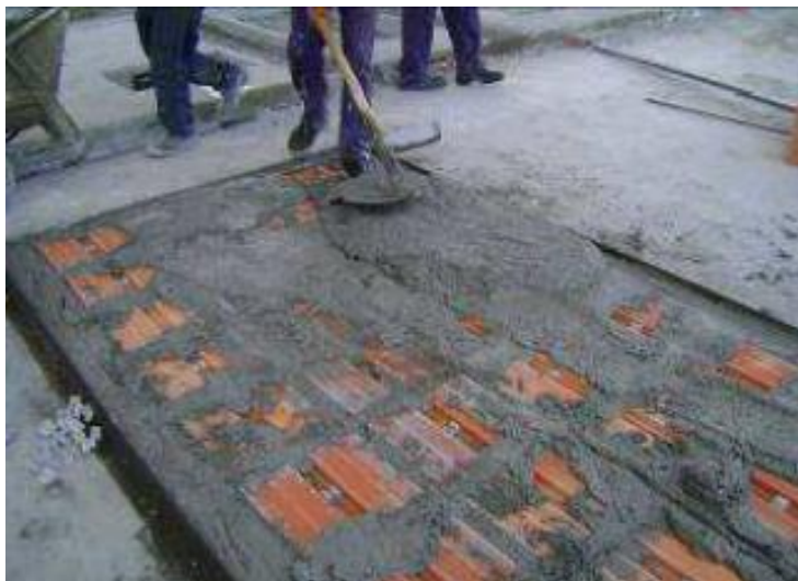
Figura 64 – Lançamento e adensamento da segunda camada de concreto do painel do sistema CASA EXPRESS
