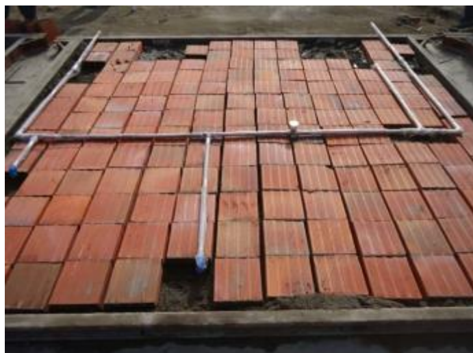
Figura 136 – Posicionamento de instalações hidráulicas sobre blocos cerâmicos
