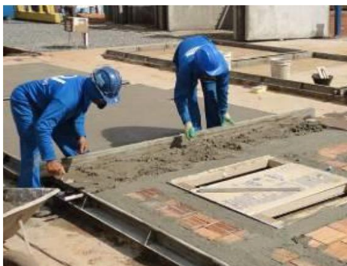
Figura 35 – Aplicação de camada de revestimento e acabamento do painel do sistema JET CASA
