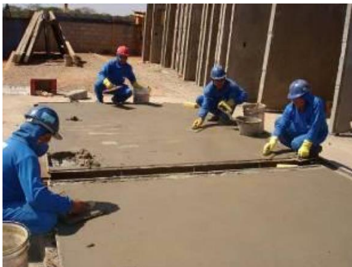
Figura 36 – Execução do acabamento do revestimento do painel do sistema JET CASA
