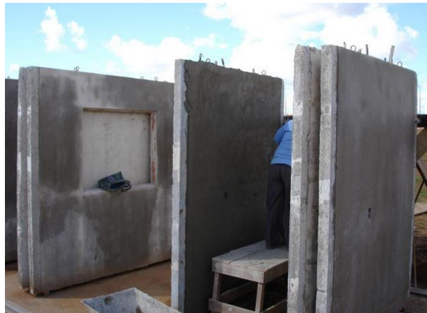
Figura 38 – Estocagem vertical dos painéis do sistema JET CASA
