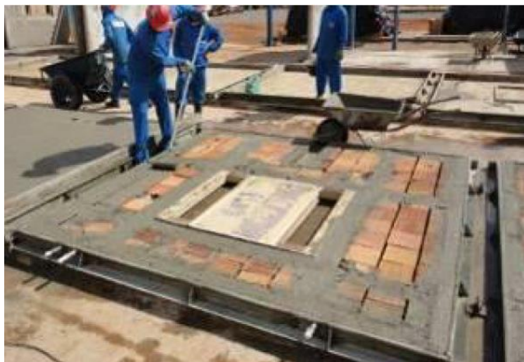
Figura 34 – Aplicação do chapisco rolado no painel do sistema JET CASA
