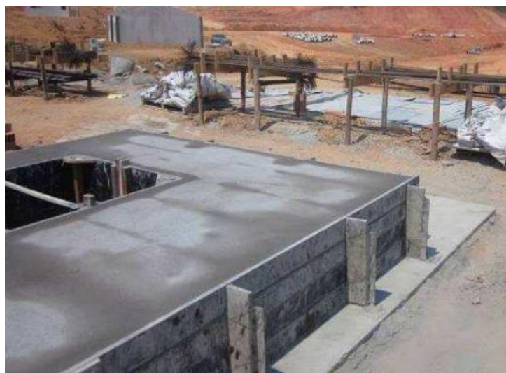
Figura 95 – Acabamento da camada superior do painel do sistema DHARMA
