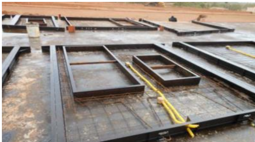
Figura 130 – Forma metálica sobre pista de produção no sistema construtivo Olé Casas
