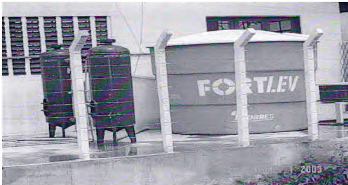
FIGURA 2 Filtros de areia e carvão ativado do Laboratório de Larvicultura da Fazenda Bom Princípio, Município de Guaiúba – CE.
