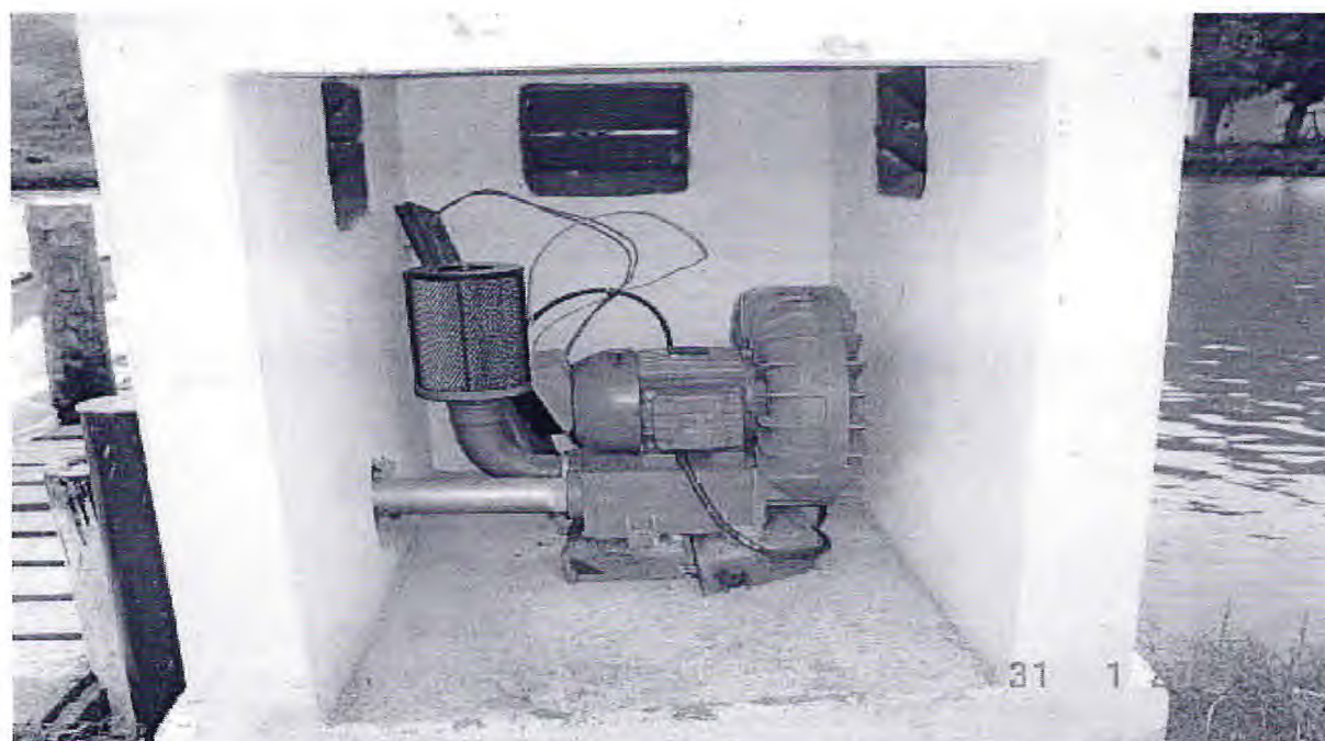
FIGURA 7 Soprador de 3 CV, destinado somente aos tanques-rede, para 2ª fase de reversão sexual da tilápia, na Fazenda Bom Princípio, Município de Guaiuba, CE.
