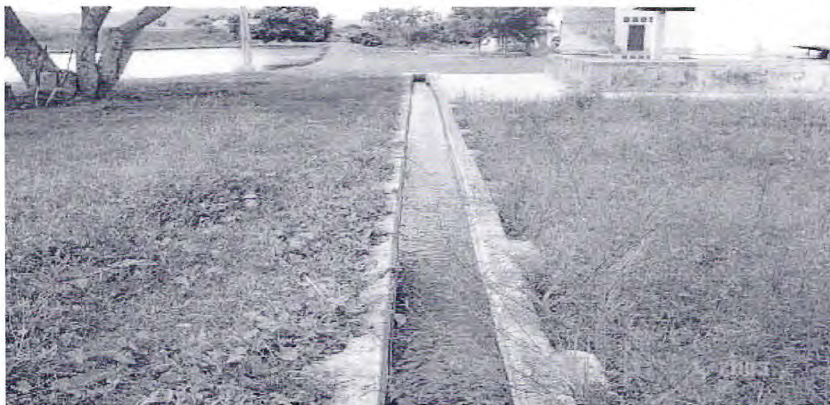
FIGURA 1 Canal de captação de água, com comprimento de 3.000 m, que percorre os viveiros da Fazenda Bom Princípio, Município de Guaiúba – CE.
