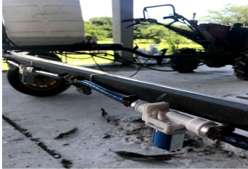
Figura 9 - Válvula Solenóide já instalada
