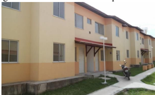
Figura 3 – Bloco contendo 08 apartamentos
