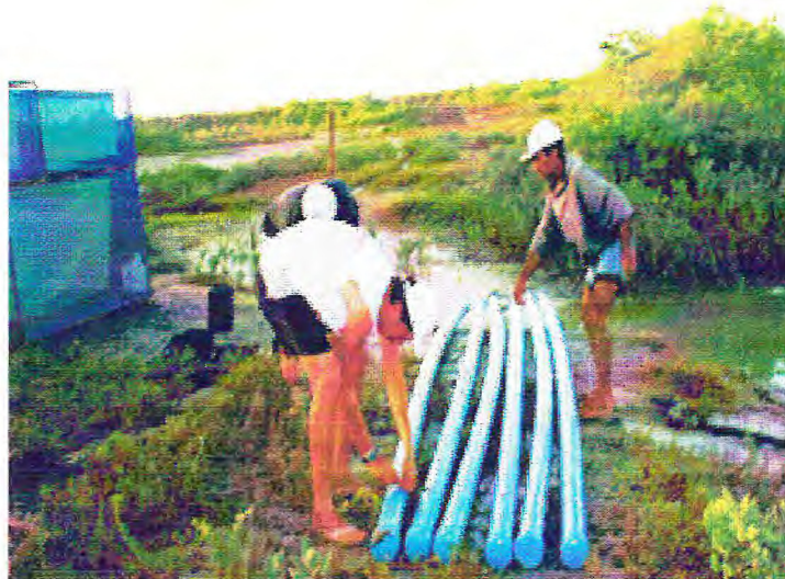
FIGURA 7- Tanques-rede, estruturas de flutuação e fundeamento sendo descarregados no Porto do Remanso.
