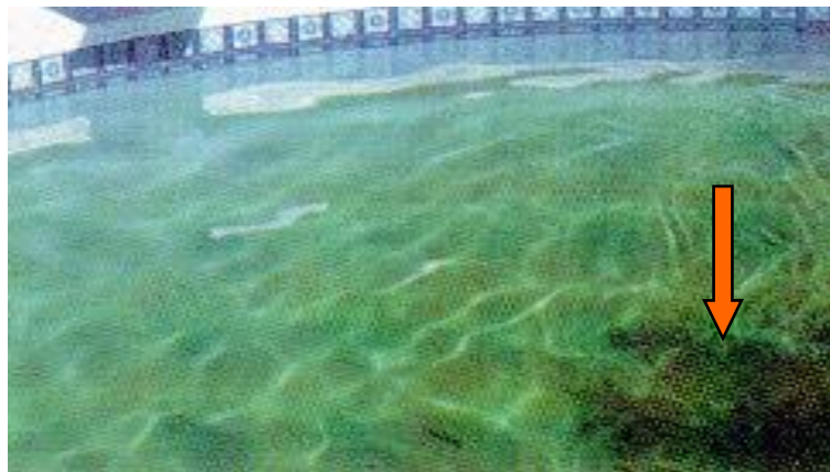
Figura 4 – Piscina com manchas metálicas
