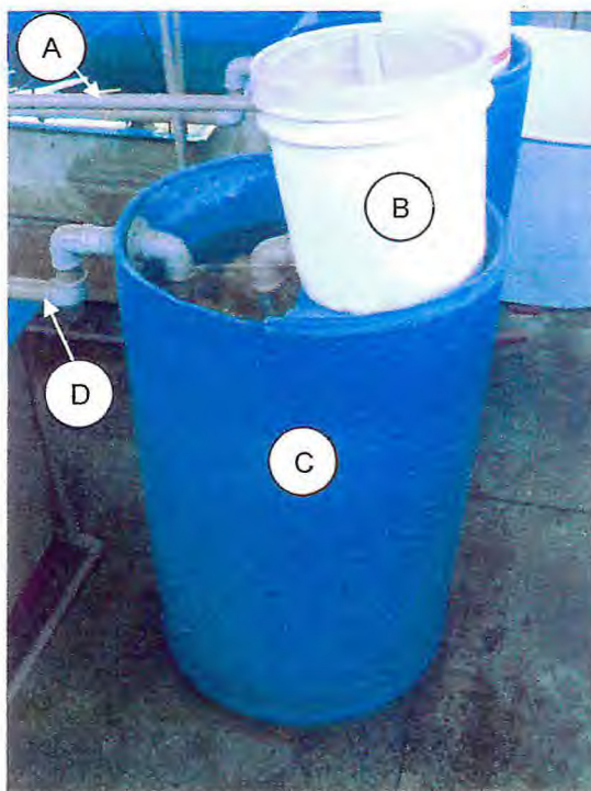
Figura 2. Filtração do sistema de manutenção. A: tomada de água para o filtro; B: filtro mecânico; C: filtro biológico e D: retorno da água para o tanque.
