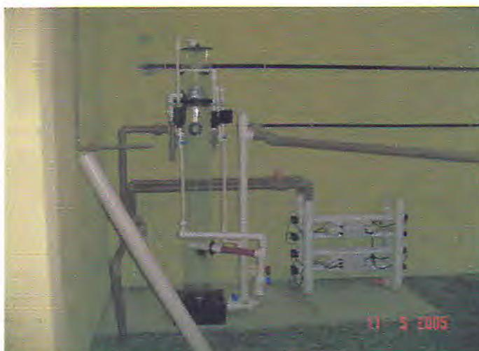
Figura 4. Skimmer vertical e unidade de filtração ultravioleta.
