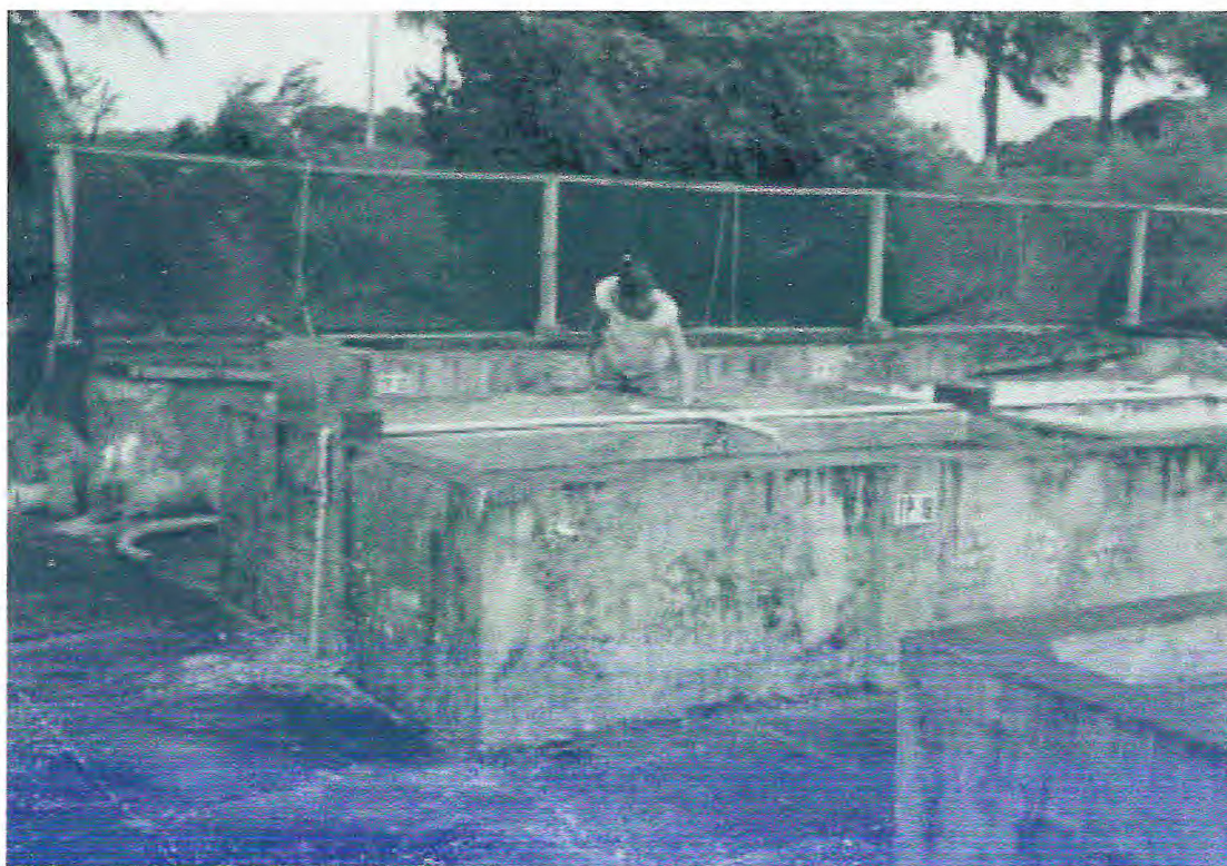
Figura 03- Tanques de alvenaria da Estação de Piscicultura Prof. Raimundo Saraiva da Costa, da UFC, Campus do Pici, em Fortaleza, Ceará, Brasil.
