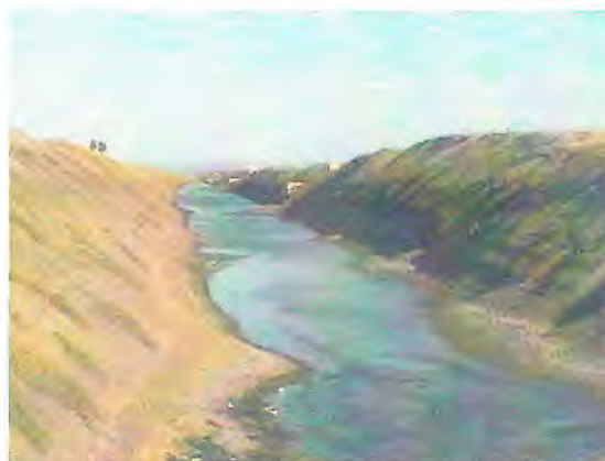
Figura 10. Canal de abastecimento dos viveiros da Fazenda Poty, Rio Grande do Norte, com nível de água baixo.
