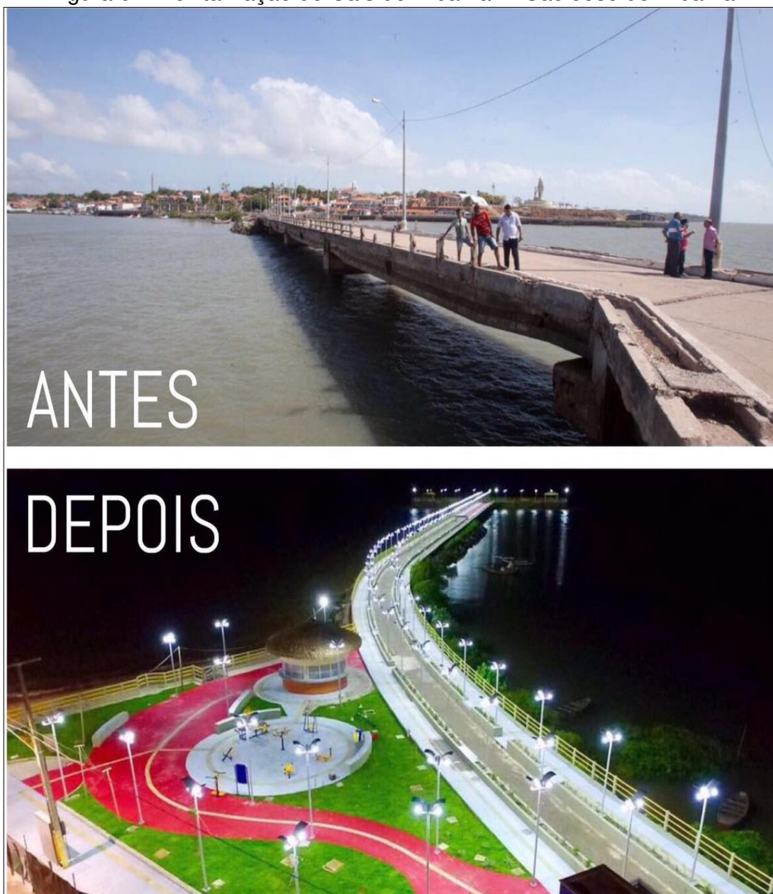
Figura 64: Revitalização do Cais de Ribamar – São José de Ribamar
