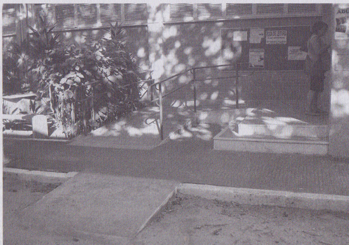
Foto 10 - Obra Projeto UFC Incluir: Rampas na Entrada do Bloco Acadêmico – Departamento de Letras
