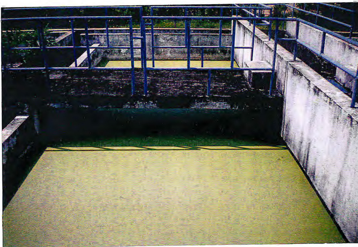
Fig. 5 - Decantador Secundário.
