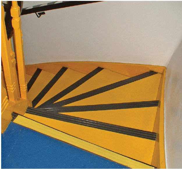
Foto 10 - Mostra escada em cores de alto contraste: degraus em amarelo e com fitas adesivas pretas no final de cada degrau. O contraste permite a visualização de profundidade dos degraus. É importante ter a sinalização de alerta no início e no final da escada, favorecendo a atenção e alerta da pessoa. O corrimão também é sinalizado com placas em texturas entrecortadas indicando a rota. Este tipo de sinalização apóia a independência do aluno.
