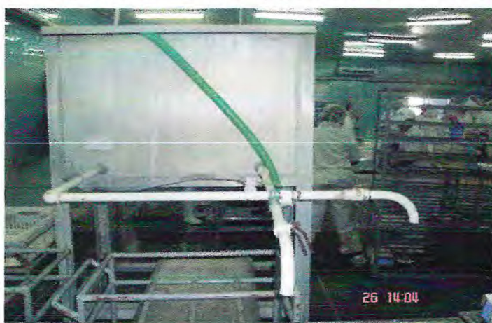
Figura 18 – Caixa de água gelada do salão de beneficiamento da INTERFRIOS.
