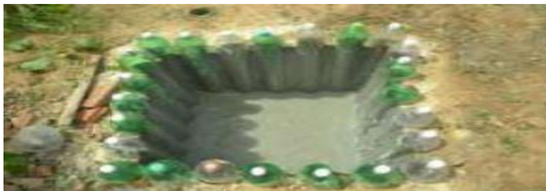
Figura 4 - Mini-BET (fossa verde) impermeabilizada com uma mistura de cimento e cola.
