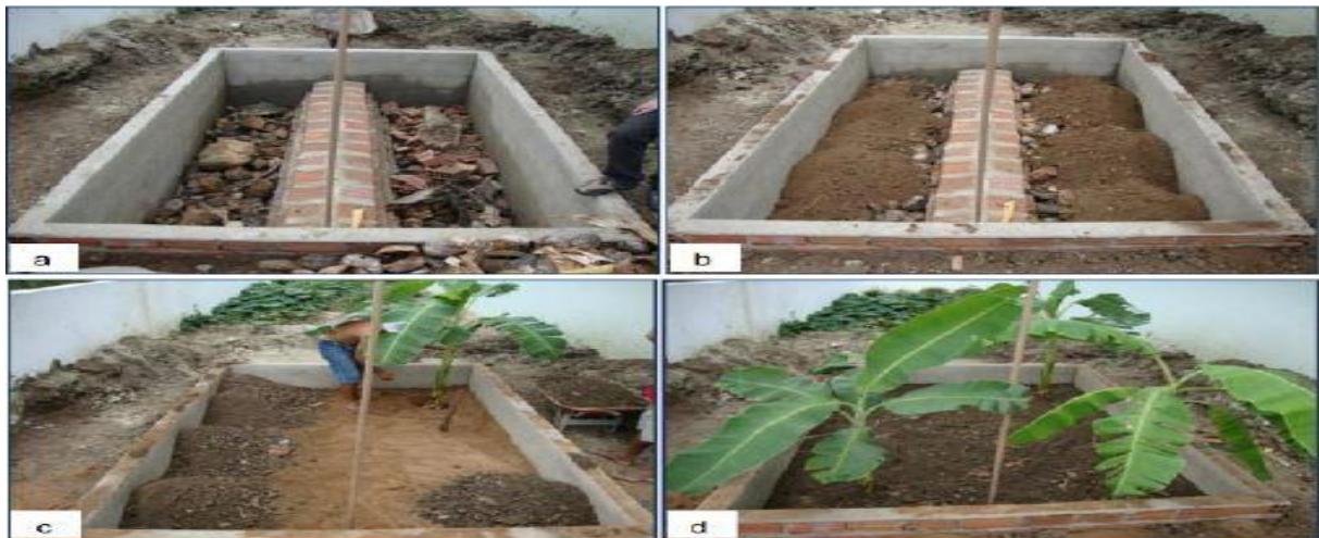
Figura 3 - Passo a passo da construção dos módulos da fossa verde no Assentamento 25 de Maio.
