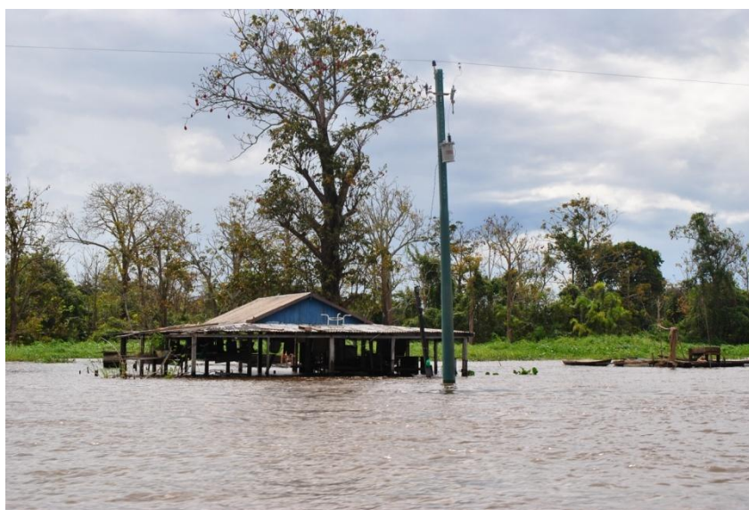
Figura 21 – Poste de distribuição de energia elétrica
