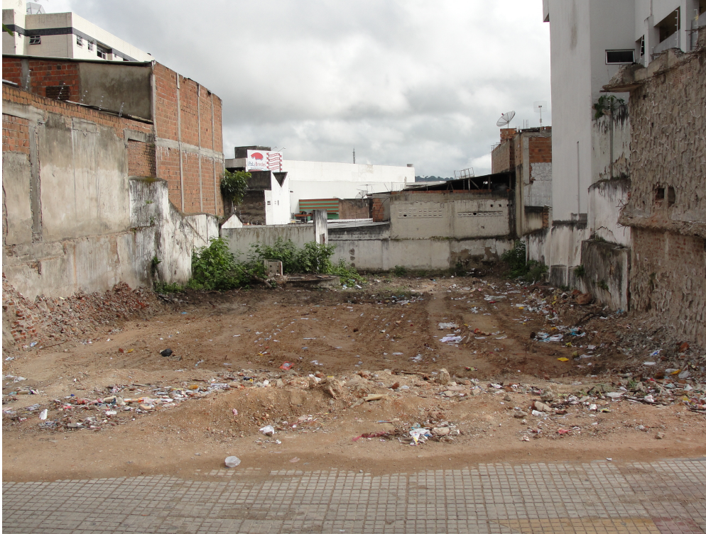
Figura 4 – Terreno em que o prédio foi demolido na Av. Floriano Peixoto, defronte a Catedral N.Sra. da Conceição.
