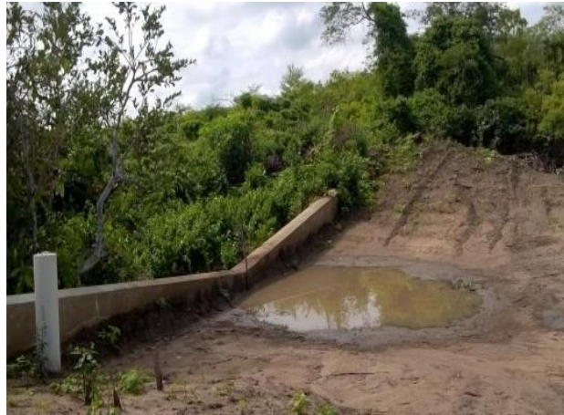
Figura 8 - Vertedouro à montante do Açude Escola.
