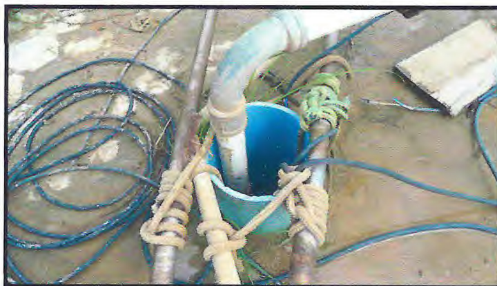
Foto 25. Bomba submersa do Poço P1, coordenadas 594500 / 9538734 na entrada da Fazenda Aqua Vida. Beberibe CE (junho 2012).
