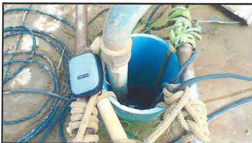
Foto 18. Tubo de PVC geomecânico nervurado - P1 (entrada da Fazenda N.V) Coordenadas 594500 / 9538734. Detalhe do tubo com o maior diâmetro 9,5. Beberibe CE (junho 2012).
