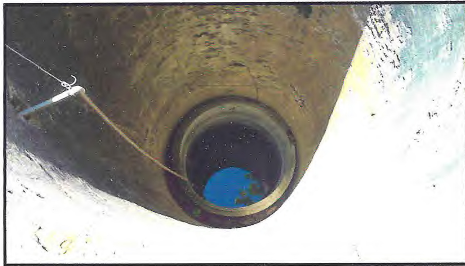
Foto 20: Cacimba construída com alvenaria e anéis de concreto, com paredes de alvenaria de 5 m de altura até chegar ao nível d'água, com água usada para irrigação de parte da Fazenda N.V Coordenadas 595033 / 9540932. Beberibe CE (junho 2012).
