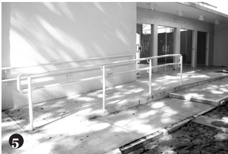
Foto 5 – Auditório Valnir Chagas – Faced/UFC. Rampa com inclinação adequada e corrimão próximo ao exigido pela NBR-9050 Foto 6 – Entrada do curso de Psicologia/UFC com rampas de acesso adequadas e vaga reservada
