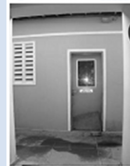
Foto 3 – Relatório de Condições de Acessibilidade Física da FEAAC
