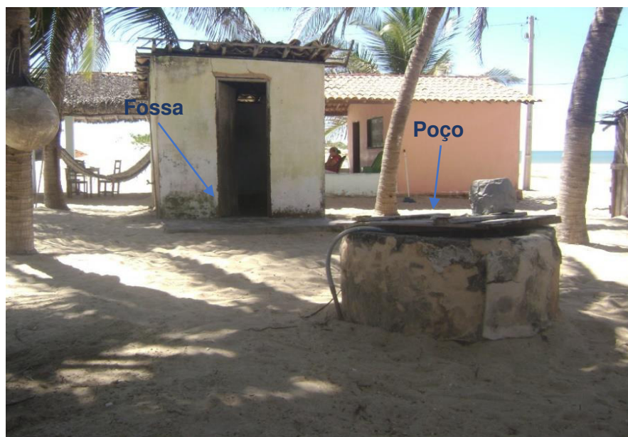
Figura 5: Poço encontrado próximo a uma fossa.
