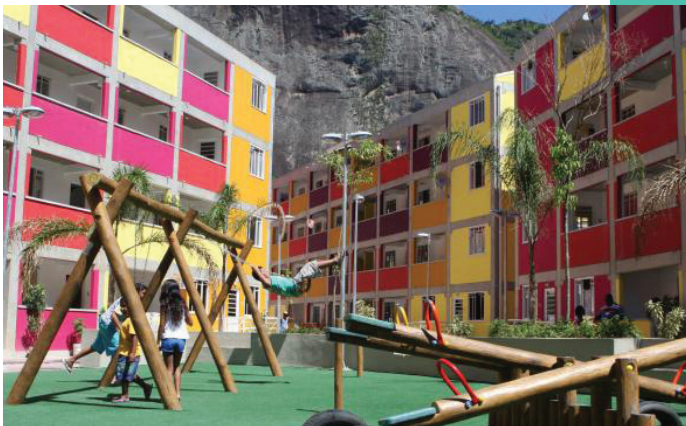
Figura 17: Novas unidades habitacionais na urbanização da favela da Rocinha - Rio de Janeiro. Fonte: http://www.rj.gov.br/web/imprensa/exibeconteudo?article-id=1627154
