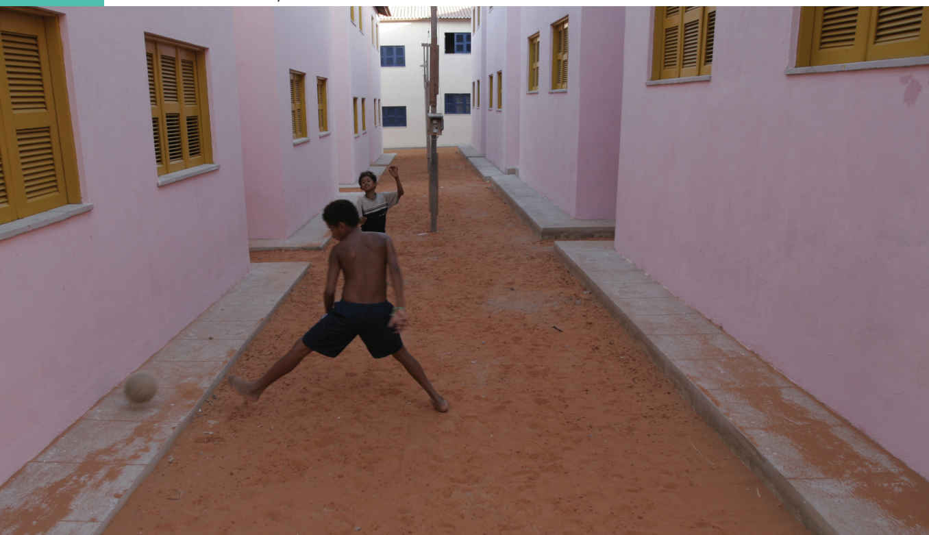
Figura 18: Interior do conjunto habitacional Maravilha. Fonte: HABITAFOR/Prefeitura de Fortaleza
