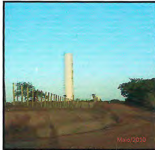
Figura-1.7 - Poço tubular e caixa d'água em anéis. (Afl. RGF-46 UTM 0462618/9598218)
