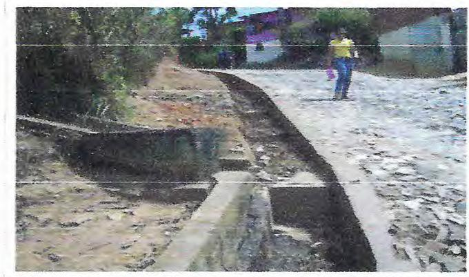
Figura 45 – Uso de canaletas para escoamento de água da chuva com batentes para diminuir a energia potencial de escoamento.
