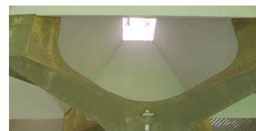
Figura 2.20: Detalhe do Pilar e Iluminação Zenital. Fonte: Arquivo Pessoal (2013).
