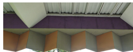
Figura 2.22: Detalhe Telhas Metálicas e Lambrequins. Fonte: Arquivo Pessoal (2013).
