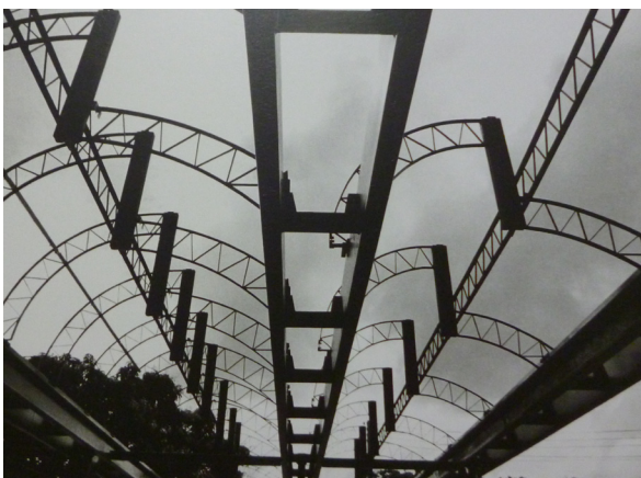
Figura 2.7: Aspecto da construção dos sheds em forma de "arco quebrado" com conexão rígida entre as treliças. Fonte: A Arquitetura de Lelé: fábrica e invenção (2010).
