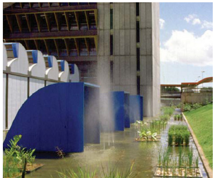
Figura 2.8: Vista do espelho d'água com as fontes de pulverização externas às galerias de ventilação. Fonte: A Arquitetura de Lelé: fábrica e invenção (2010).
