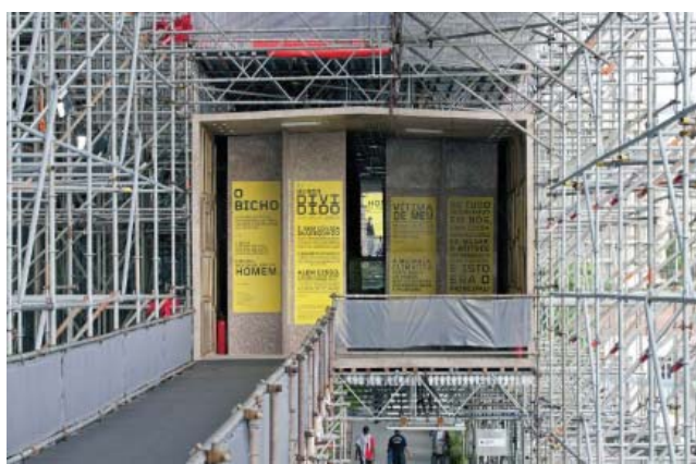
_imagem os blocos de salas agem como contravetamento da estrutura
