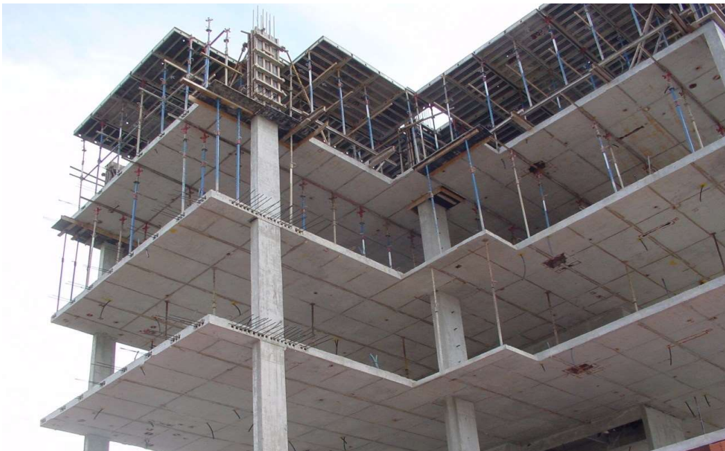
Figura 5 - Sistema de lajes maciças planas
