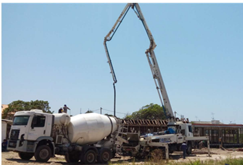
Figura 14 - Bomba lança para bombeamento de concreto
