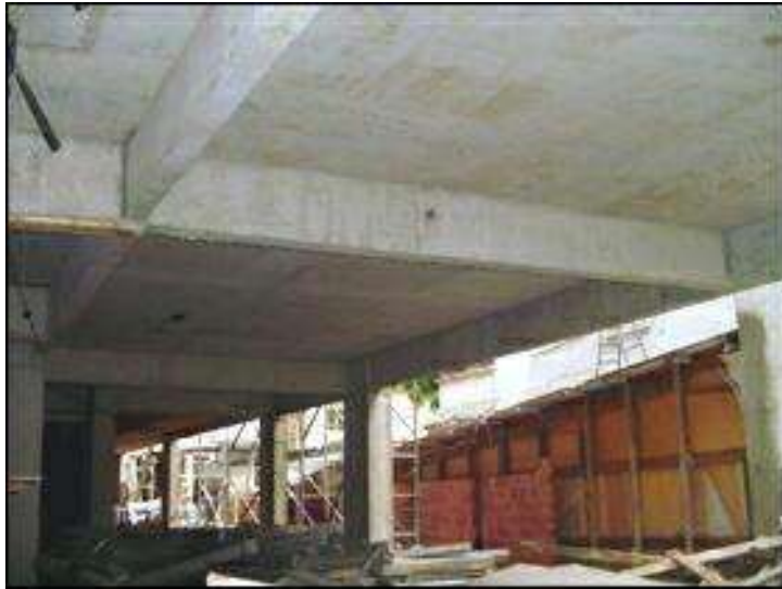
Figura 1 - Sistema estrutural de lajes maciças com vigas
