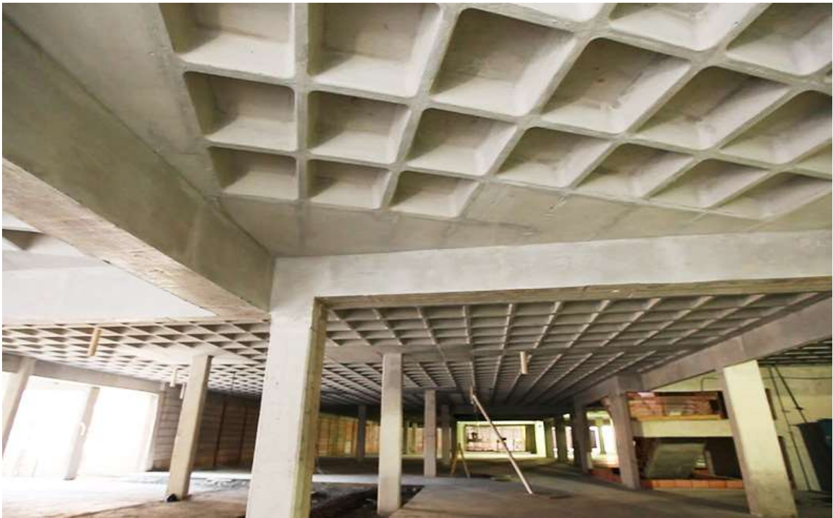
Figura 2 - Sistema estrutural de lajes nervuradas
