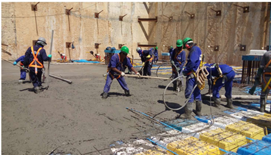
Figura 13 - Execução da concretagem de uma laje
