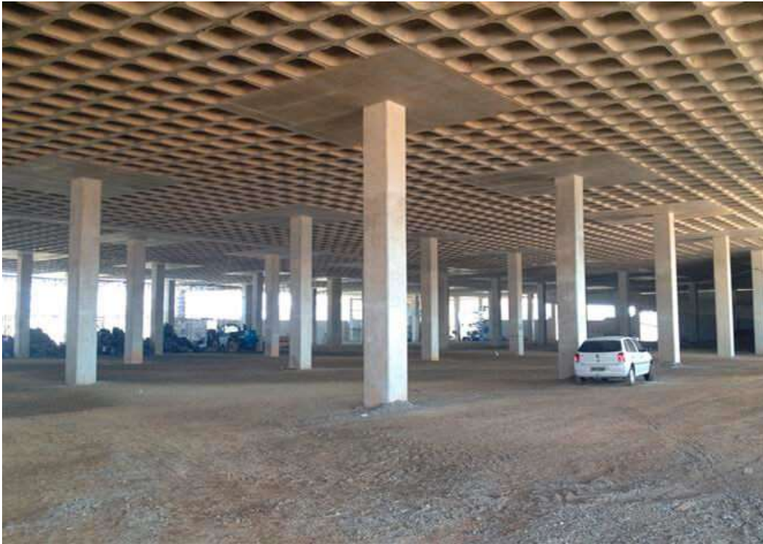
Figura 3 - Sistema estrutural de lajes nervuradas lisas
