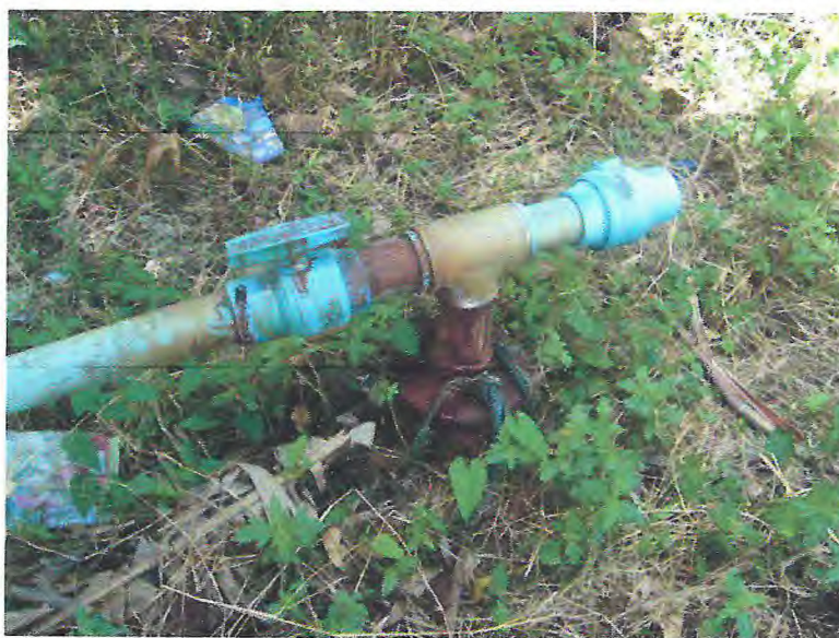
Fotos 17: Observa-se o poço P55 revestido de ferro - SÃO PEDRO, Fazenda Domingos Miranda (Coord.: 9193160/467741). Junho/2012
