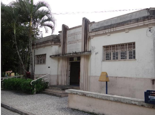
Figura 40 - Fachada dos Correios.
