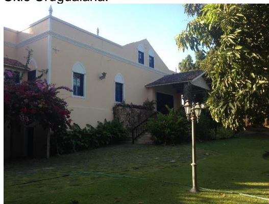
Figura 60 - Fachada externa de Casarão no Sítio Uruguaiana.
