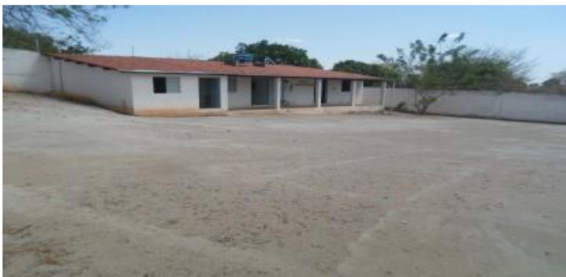
Figura 6 – Estrutura interna da ACC.
