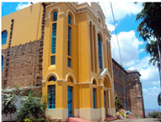
Figura 07 – Escola Apostólica que não chegou a ser concluída.
