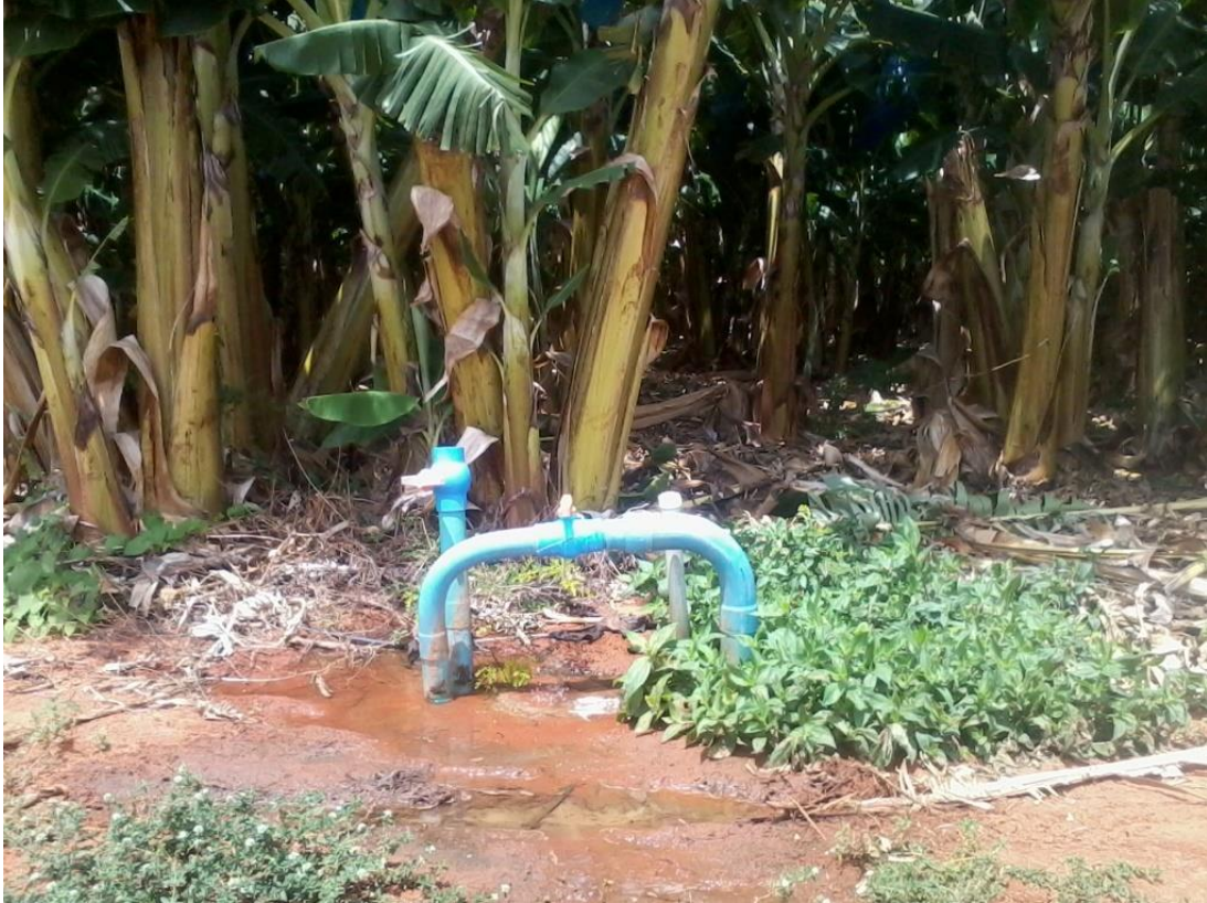
Figura 12 - Cavalete de setorização no Perímetro Irrigado Tabuleiros de Russas, CE.
