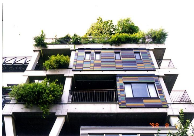
Fig. 38: Foto de detalhe na fachada
