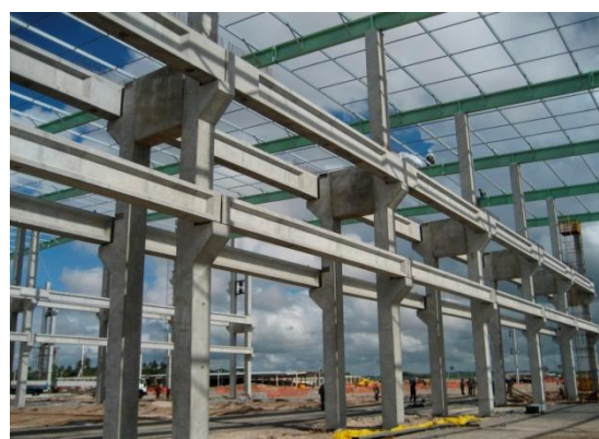
Fig.14: Obras com estruturas convencionais pré-moldadas de concreto, produzidas pela T&A, empresa local, do município de Maracanaú-CE. Acima e à esquerda, a sede da transportadora LDB, em Fortaleza-CE. Acima e à direita, o estaleiro atlântico sul do porto de Suape-PE. Abaixo, o hospital IMIP, em Recife-PE.
