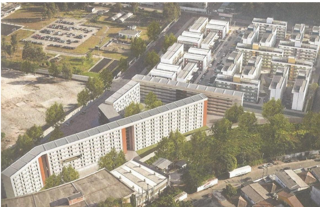
Fig. 11: Vista aérea do conjunto.
