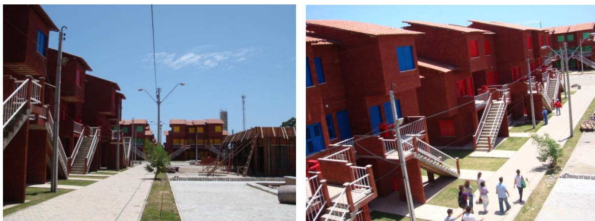
Figs. 50 e 51: Vista do pavimento superior de uma das habitações e vista do passeio do conjunto habitacional do Vila do Mar.
