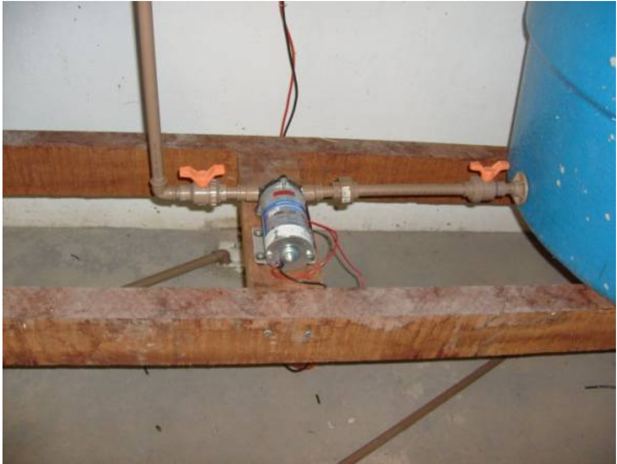
Figura 3 – Motor-bomba
