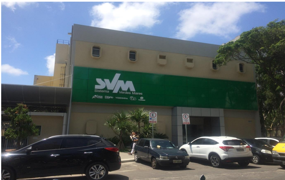
Figura 18 - Fachada do prédio do Sistema Verdes Mares em Fortaleza.
