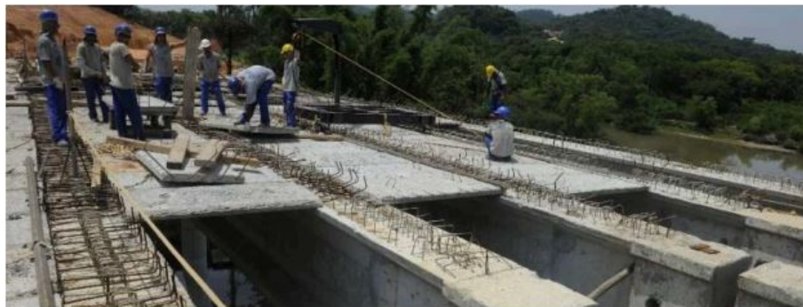
Figura 15 – Pré-lajes na ponte do Complexo Viário, em Blumenau-SC.
