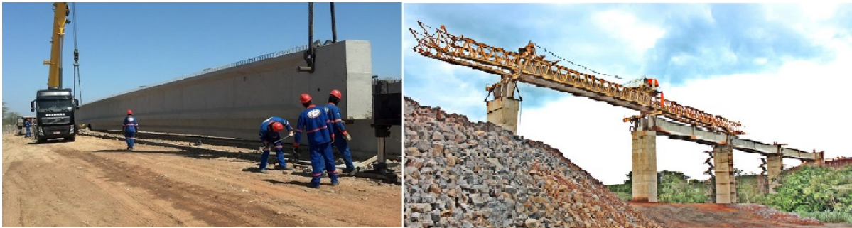
Figura 14 – Técnicas de içamento por guindaste (esq.) e treliça (dir.).
